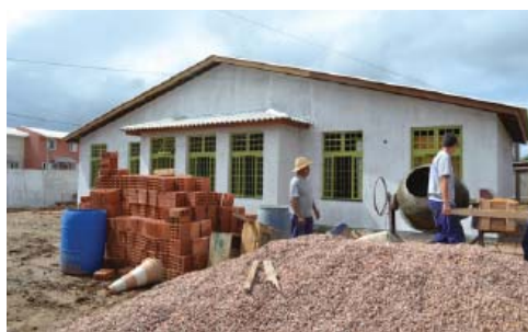
Construção da Escola de Educação Infantil no Conjunto Habitacional Porto Novo.
