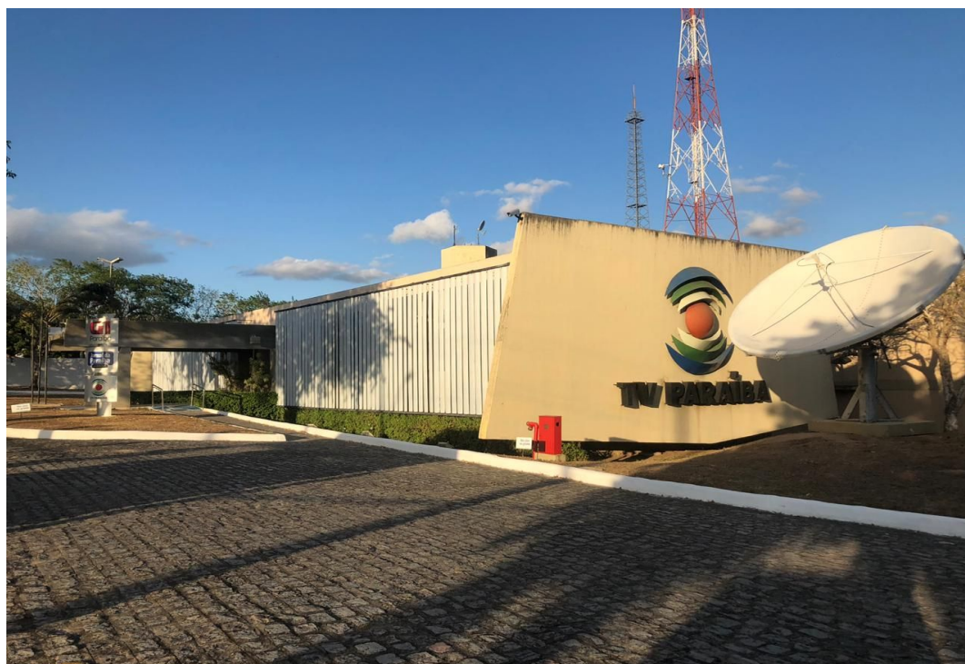
Figura 3: Sede da TV Paraíba localizada em Campina Grande
