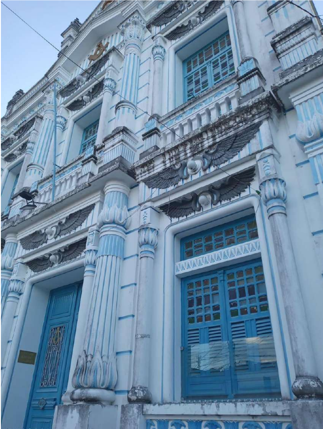
Figura 15- Edifício da Loja Maçônica Branca Dias, na Av. General Osório
