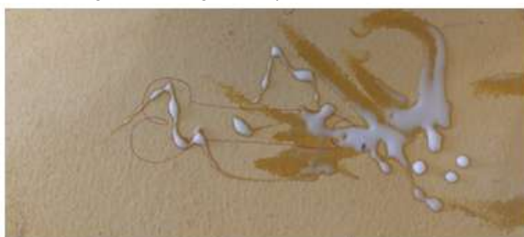
Imagens 42 - Registro da parede da escola, 2023
