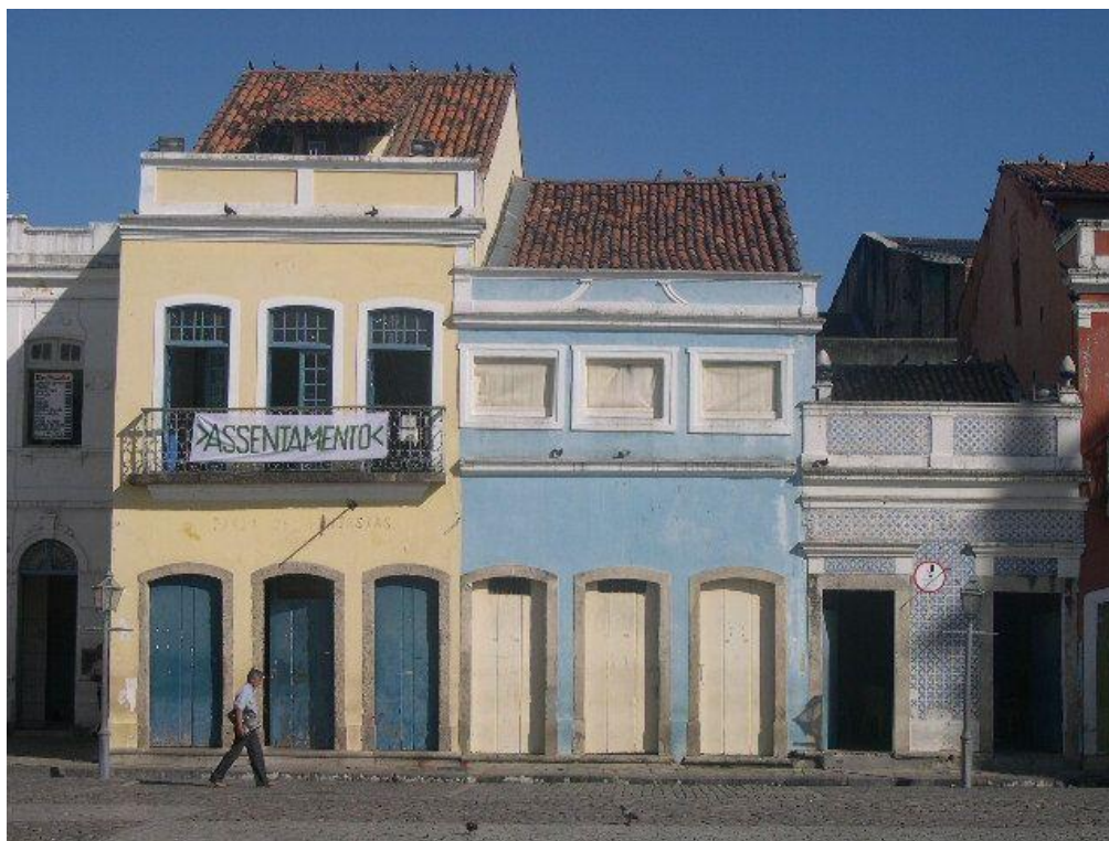
Fotografia 11 - Fachada da casa que recebeu a residência Assentamento, 2003.
