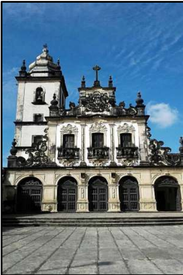
Fig. 58 – Igreja de São Francisco em João Pessoa/PB
