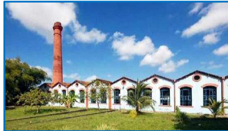
Fig.39 – Fachada do Colégio Cintra, antiga fábrica de tecidos do Rio Anil
