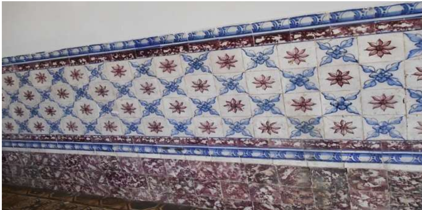
Fig. 62 – Revestimento do tipo silhar no corredor da Igreja de Santana, em São Luís/Ma
