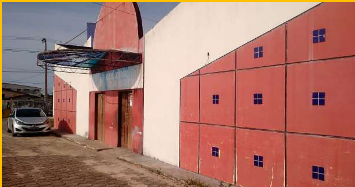
Fig. 75, 76, 77 – Instalações internas da escola Neiva Moreira de Santana
