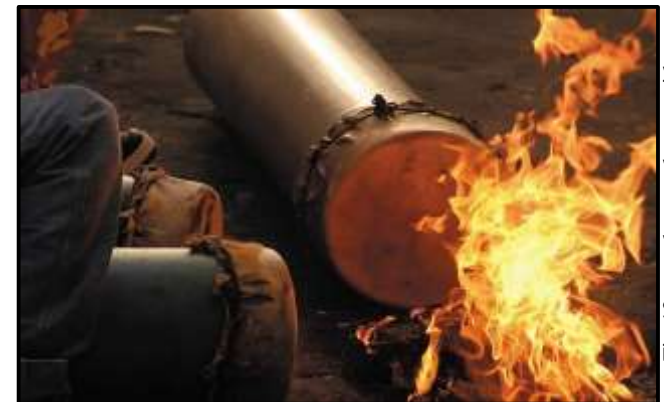
Fig.12 – tambor sendo aquecido
