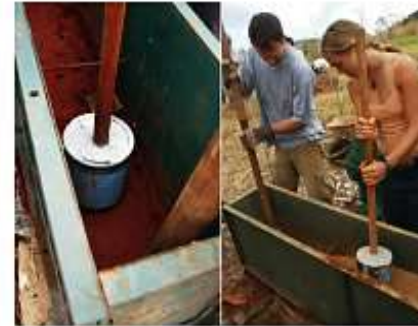
Fig.42,43 e 44 – Materiais e demonstração do uso da técnica de taipa de pilão.
