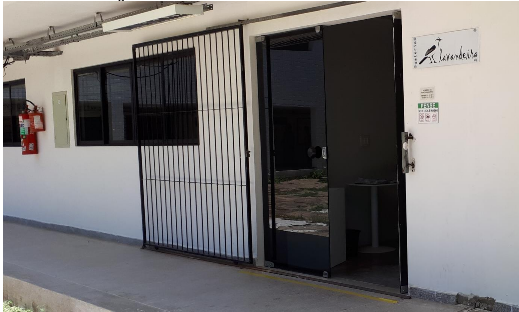
Figura 54 – Porta de entrada da Galeria Lavandeira.
