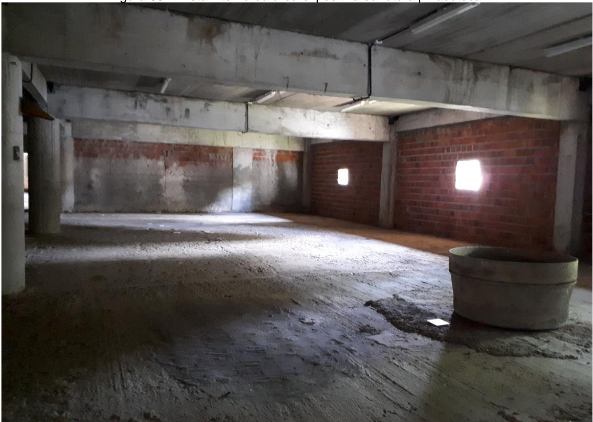
Figura 68 – Vista interna da área expositiva da futura pinacoteca.
