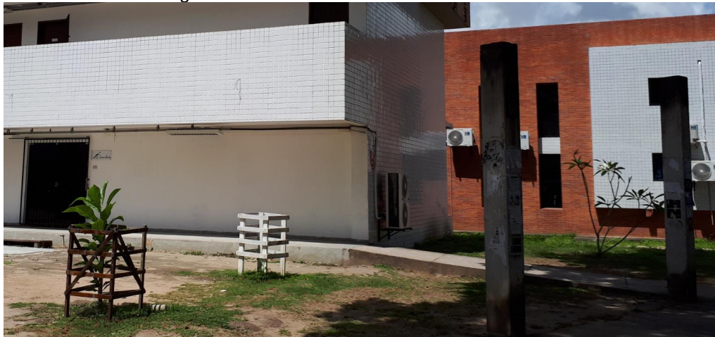
Figura 51 – Acesso à Galeria de Arte Lavandeira
