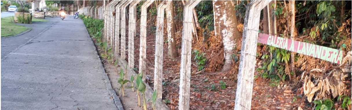
Figura 31 – Sinalização Galeria Lavandeira
