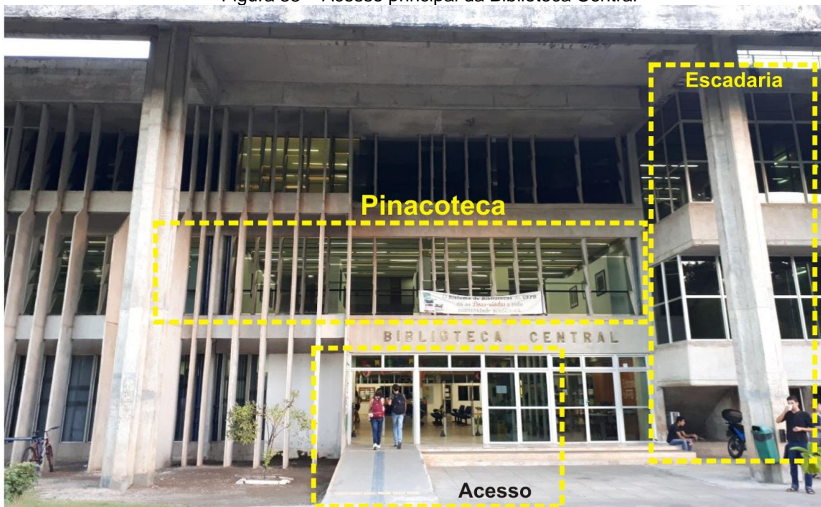
Figura 38 – Acesso principal da Biblioteca Central
