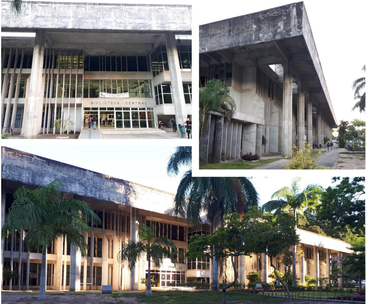
Figuras 9 – Vistas da fachada principal da Biblioteca Central da UFPB.
