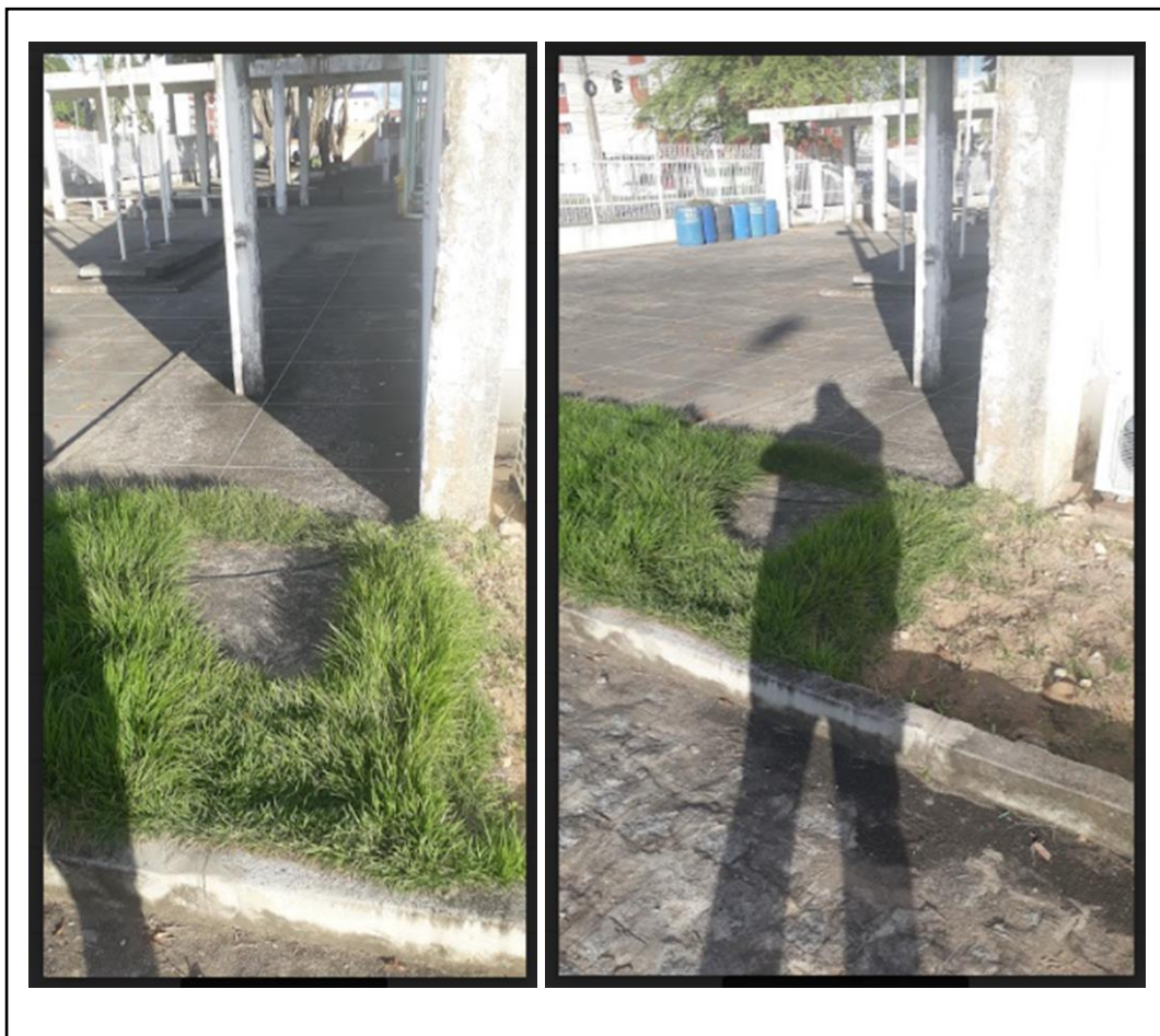
Figura 21: Acesso à entrada principal do prédio antigo para as pessoas que vêm do estacionamento principal.
