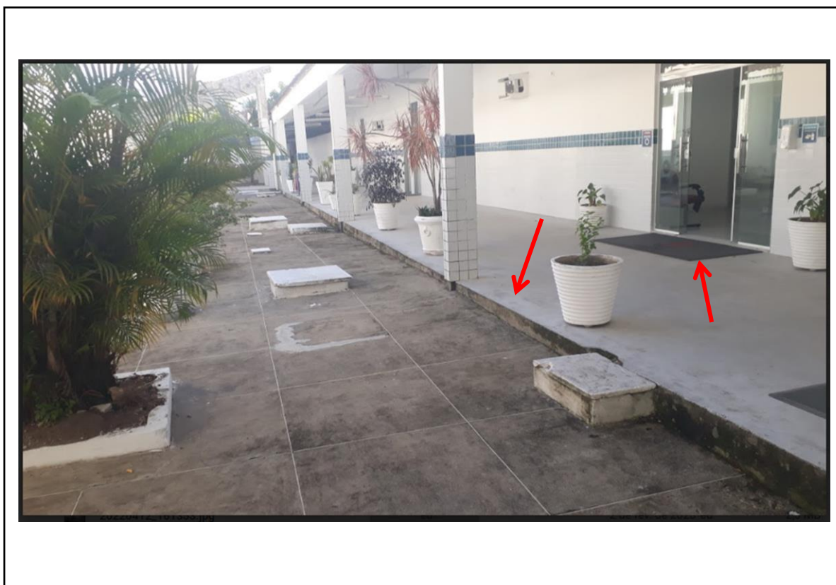
Figura 23: Corredor de acesso, depois da entrada principal, a todo o prédio antigo do Campus V – UEPB.
