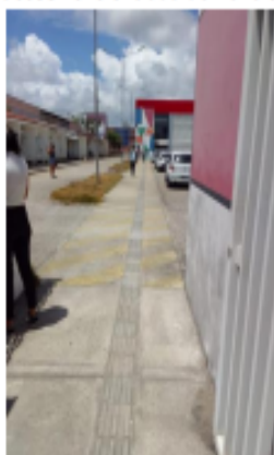
Figura 1 - Rota acessível entre entrada do campus acessível e entrada do novo edifício
