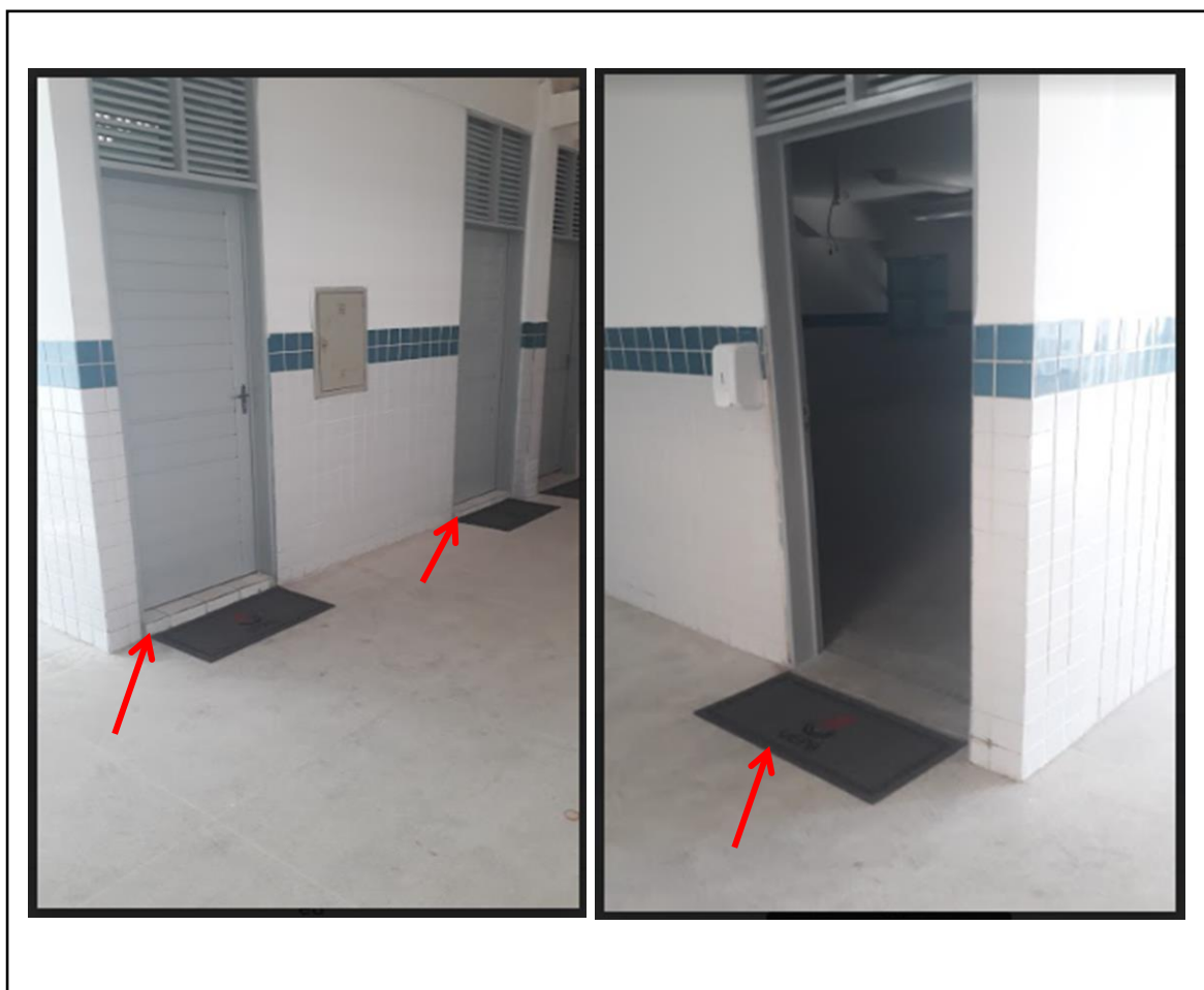
Figura 25: Acesso às salas de aula no prédio antigo do Campus V – UEPB.
