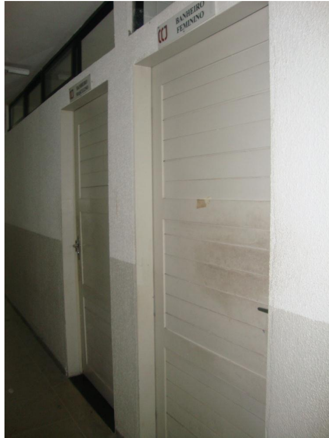
Figura 03 – Entrada do banheiro masculino e feminino no CCJ.
