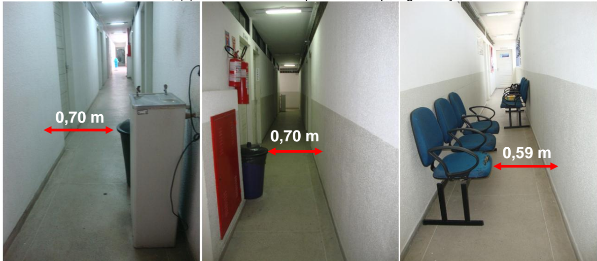
Figura 16 – Corredores internos: (a) balde de lixo próximo ao bebedouro; (b) balde de lixo próximo ao hidrante; (c) cadeiras externas próximas da pós-graduação.
