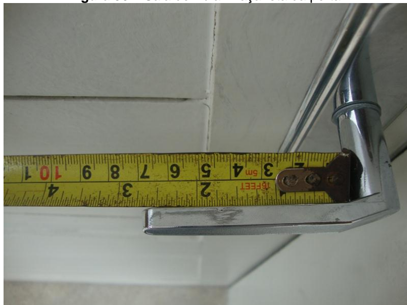
Figura 30 – Sala de Aula: maçaneta da porta.
