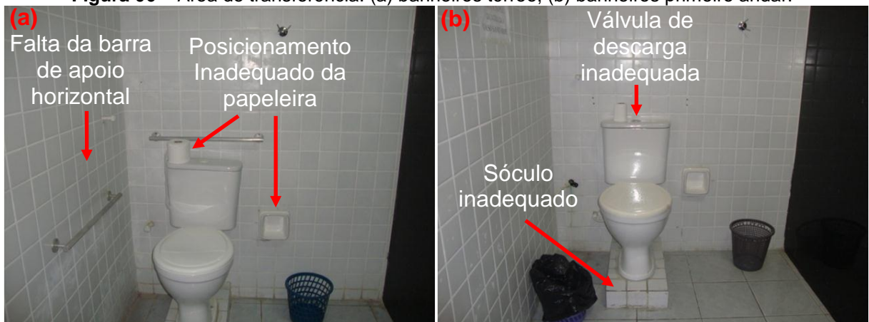
Figura 06 – Área de transferência: (a) banheiros térreo; (b) banheiros primeiro andar.
