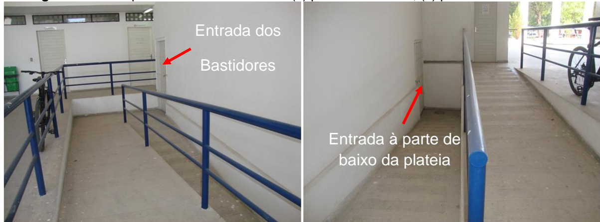
Figura 31 – Rampa de acesso ao auditório: (a) patamar de início; (b) patamar intermediário.
