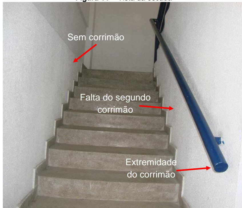
Figura 11 – Vista da escada
