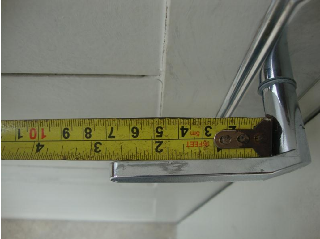
Figura 20 – Sala de Aula: maçaneta da porta.
