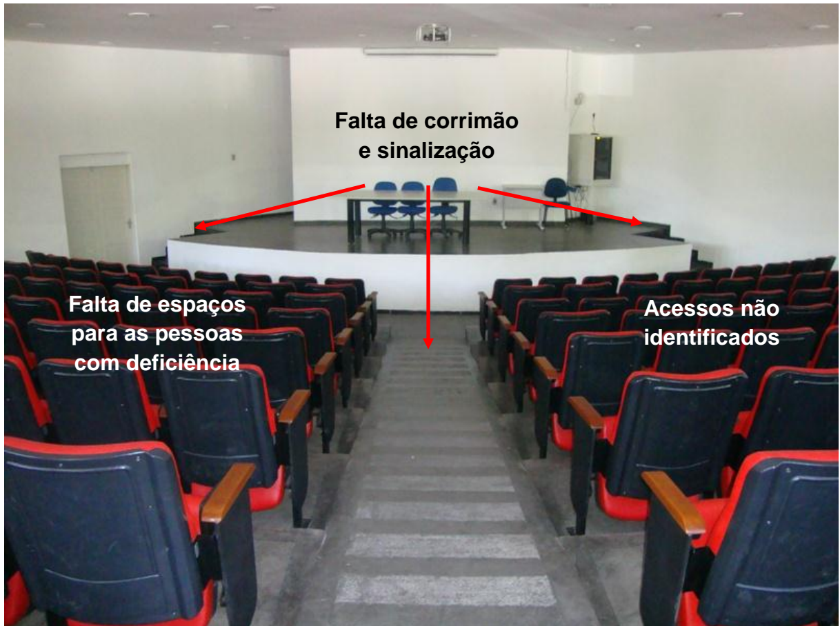
Figura 32 – Auditório: vista interna.
