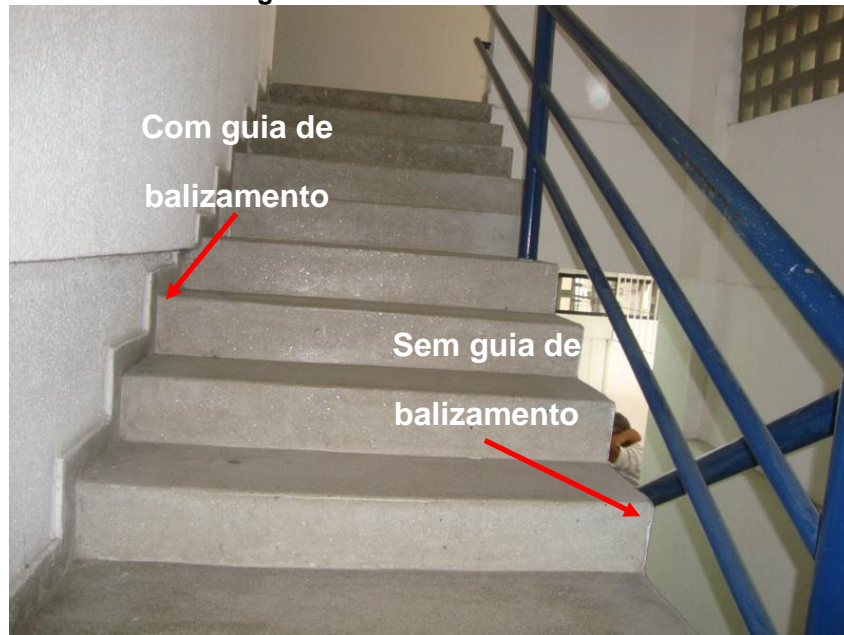
Figura 09 – Guia de balizamento
