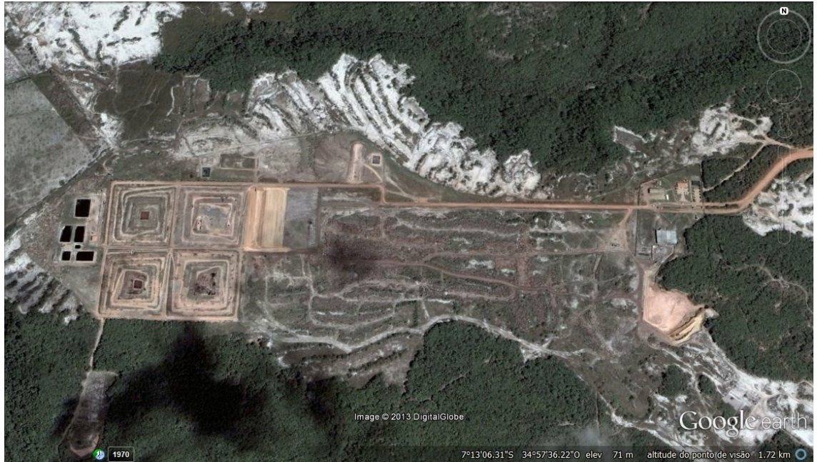
Figura 3: Vista aérea do Aterro Sanitário de João Pessoa. Fonte: Google Earth.
