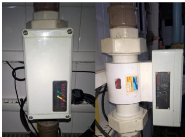
Figura 4.5 - Medidor de vazão eletromagnético - vista frontal e lateral (Flores, 2021).
