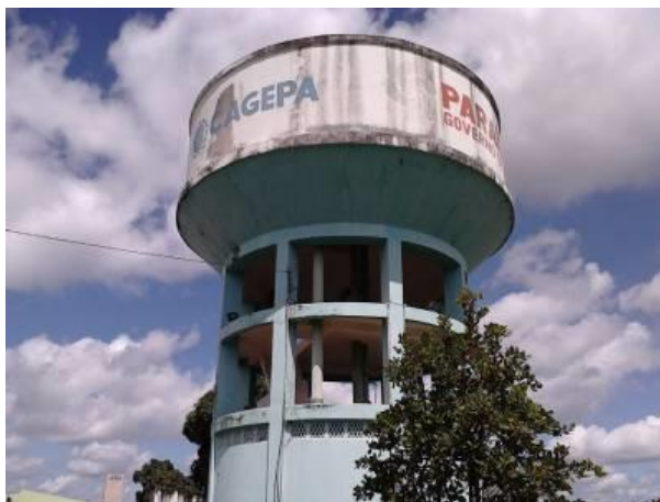
Figura 21: Vista reservatório R3 elevado (R3E).
