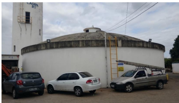
Figura 18: Vista reservatório R1 apoiado (R1A) e ao fundo o R1 elevado (R1E)
