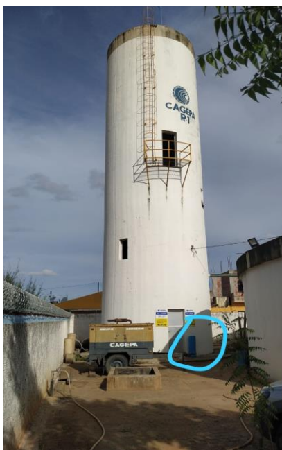
Figura 40: Acesso ao reservatório elevado (R1E).
