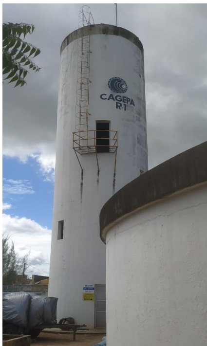
Figura 19: Vista reservatório R1 elevado (R1E)
