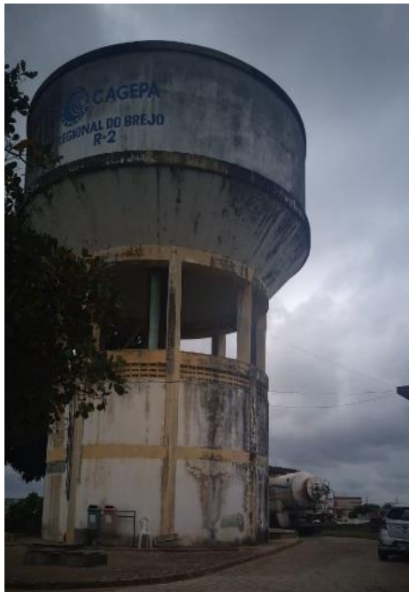
Figura 20: Vista reservatório R2 elevado (R2E).
