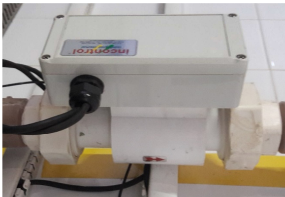
Figura A.8 – Vista do medidor de vazão eletromagnético em PVC. Fonte: CATÁLOGO INCONTROL (2016).
