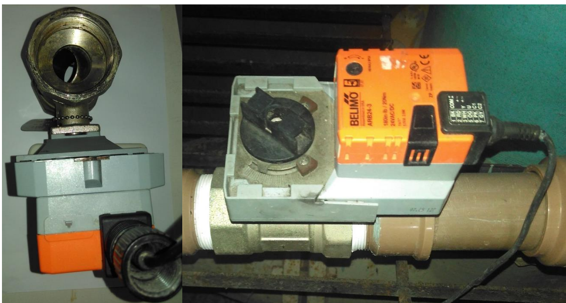
Figura 9 - Válvula Proporcional (ARB24-3)
