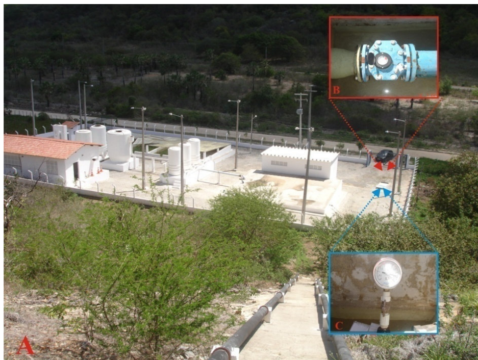
Figura 4.6 – Estação de tratamento de água, macromedidor e manômetro analógico
