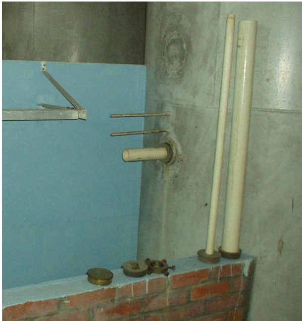
Figura 25 - Foto da saída do tubulão
