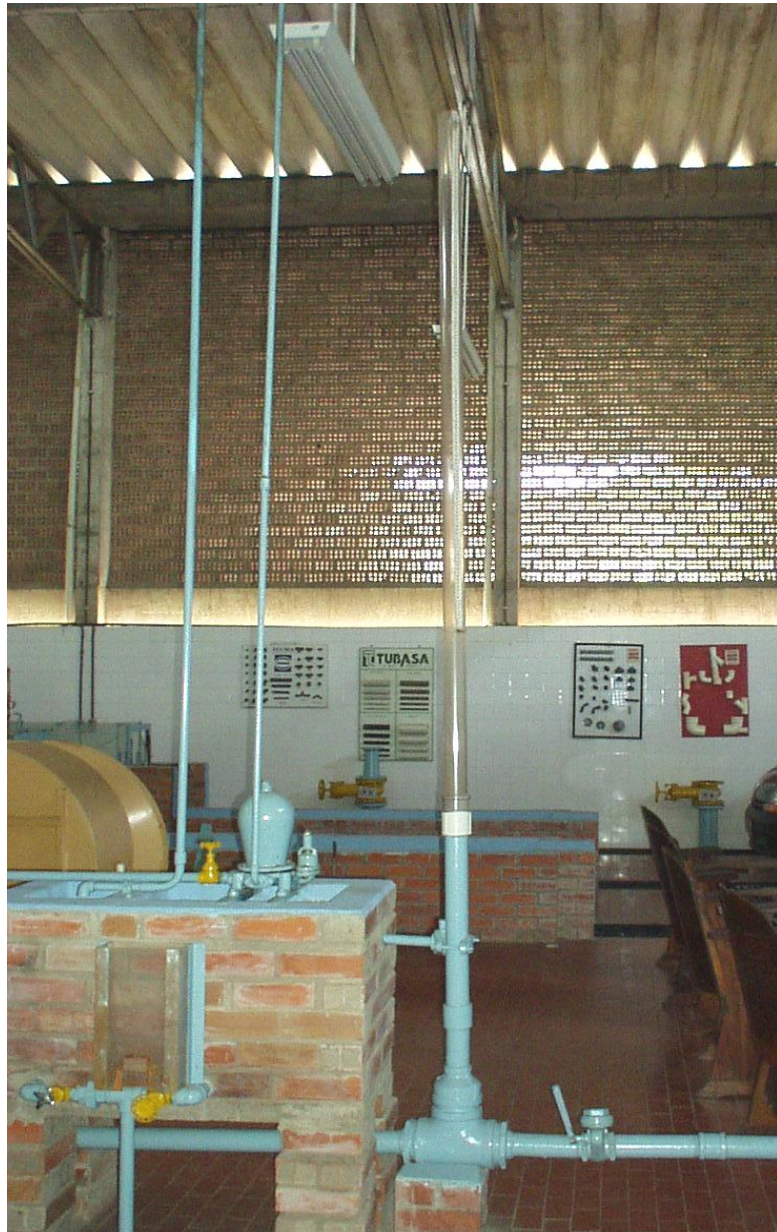
Figura 34 - Foto da Experiência 18 - tubulação que permite visualizar o golpe de Aríete
