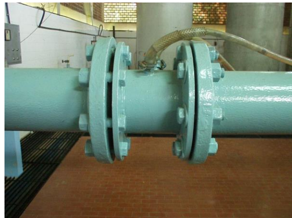
Figura 9 - Foto da placa de orifício
