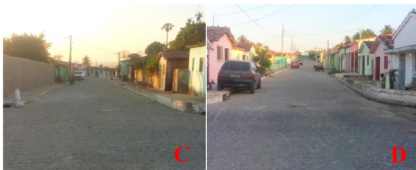
Figura 27: C e D Rua Professora Eulina Bezerra Pessoa após canalização e pavimentação Foto: Mayara Soares. Data: 30/10/2016
