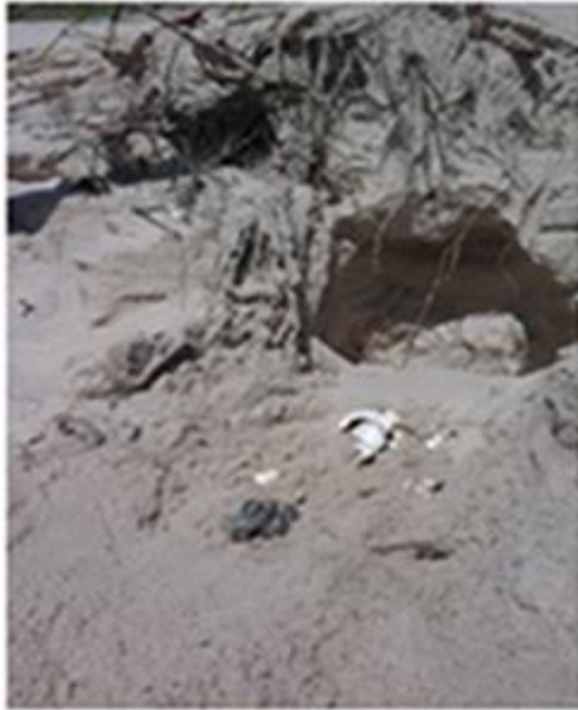
Figura 7 Ausência da cobertura vegetal
