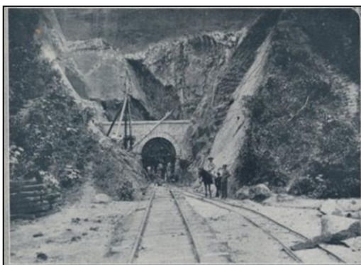
Foto: Construção da boca norte do Túnel da Viração
