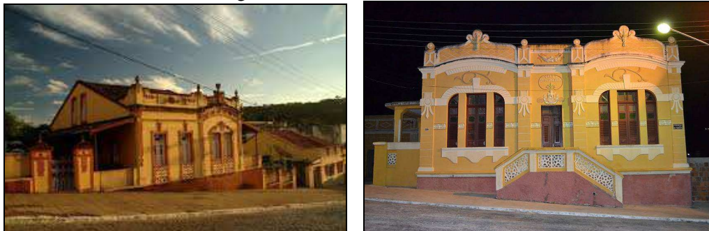
Imagem 4 e 5-Fachada dos casarões
