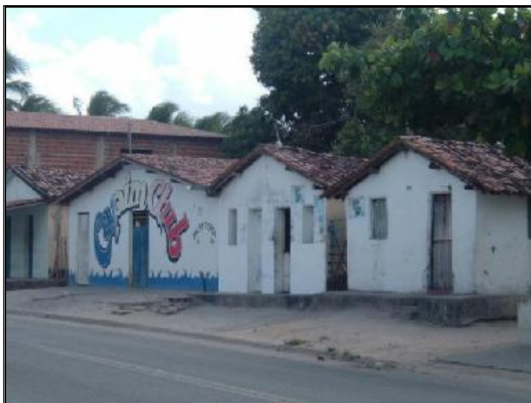
Foto 3.2. Aspectos da cidade de Capim, na Av. São Sebastião. Observamos residências em taipa, bem como a sede de um dos equipamentos de lazer da cidade. Foto: Josineide Bezerra, março/2005.
