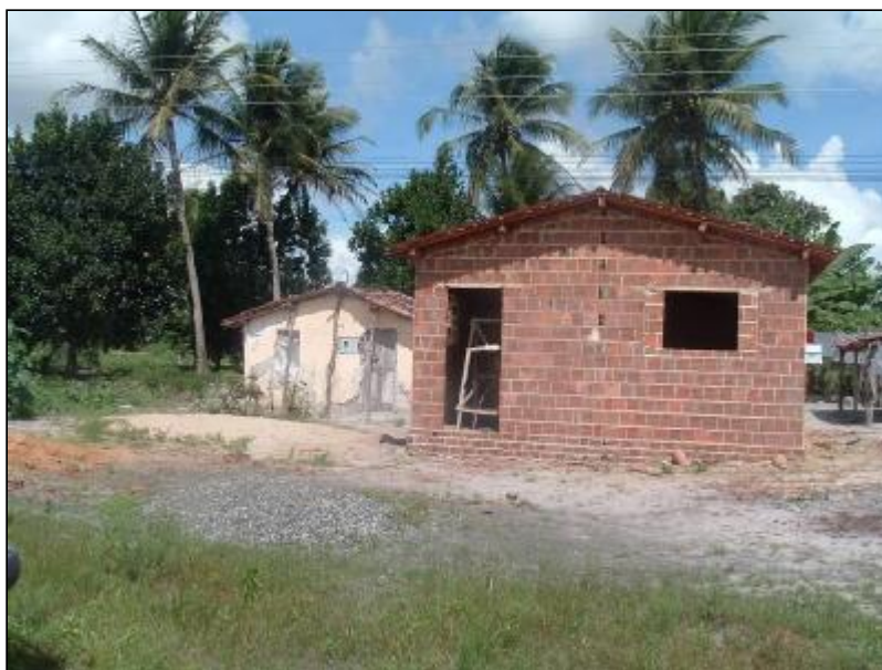
Foto 3.6. Programa de substituição de casas de taipa por casas de alvenaria, em Capim. Foto: Josineide Bezerra, julho de 2006.
