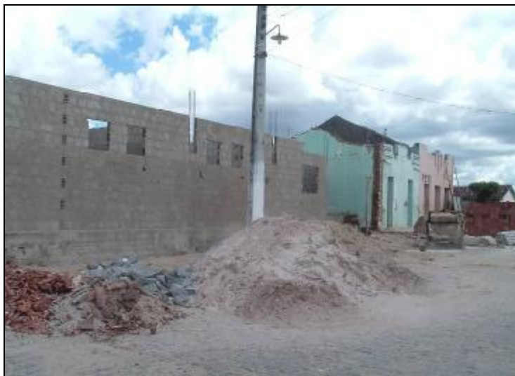
Foto 3.4. No primeiro plano, as obras da futura sede da Prefeitura de Sobrado. Ao fundo, a antiga sede do PETI. Foto: Josineide Bezerra, fevereiro de 2006.
