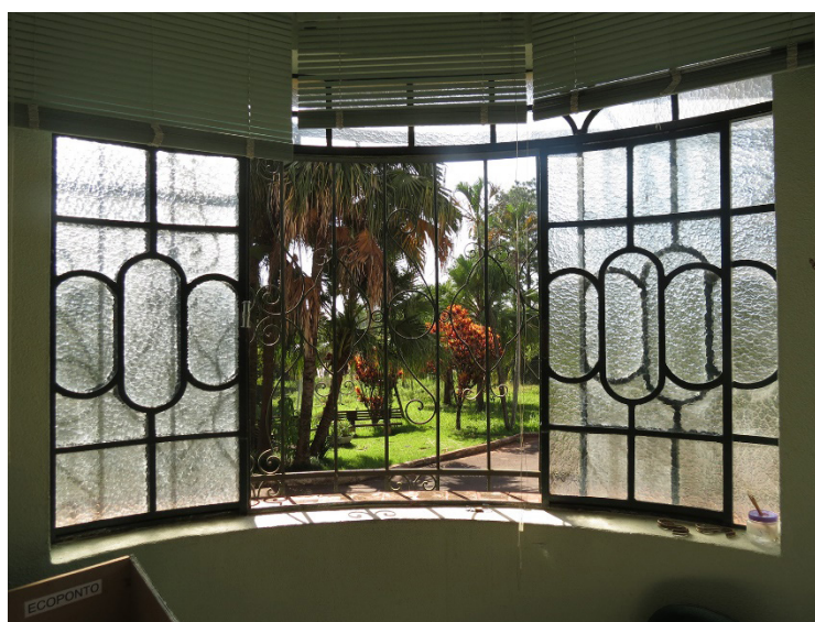
Figura 02: Janela curva em ferro, em funcionamento perfeito até os dias de hoje. Foto: André Frota Contreras Faraco.
