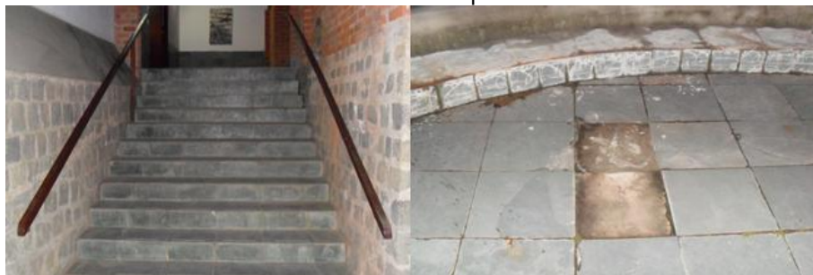
FIGURA 7 - Escada e piso interno
