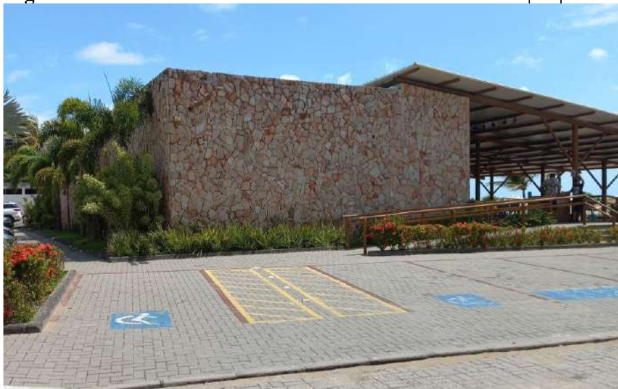
Figura 4- Estacionamento sinalizado de um dos estabelecimentos pesquisados
