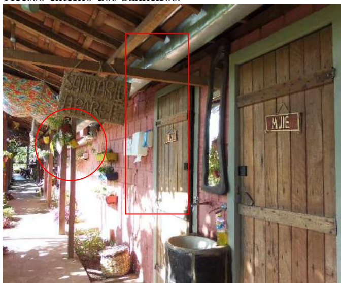
Figura 7: Acesso externo dos banheiros.
