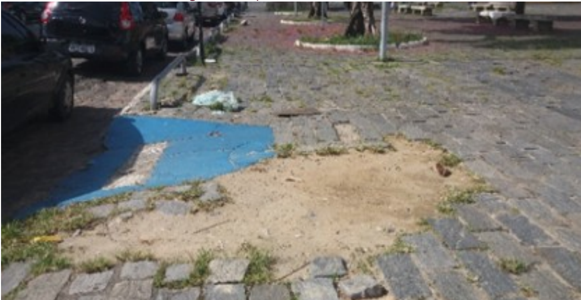
Figura 3: rampa de acesso a cadeirantes
