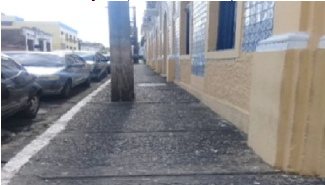
Figura 7: Calçada lateral do Casarão dos azulejos.
