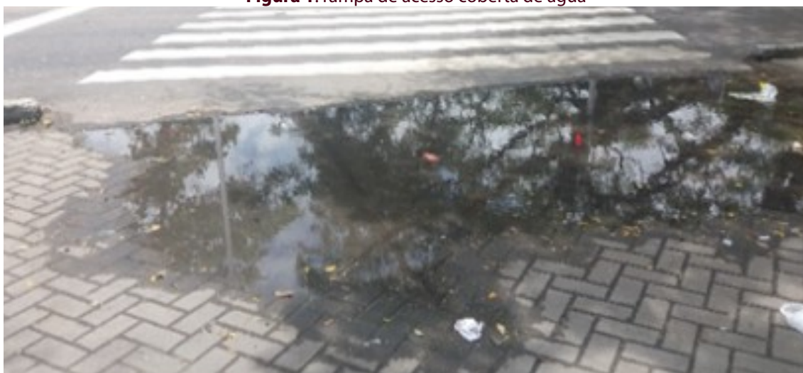
Figura 1: rampa de acesso coberta de água
