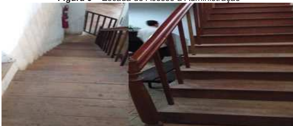
Figura 3 – Escada de Acesso a Administração
