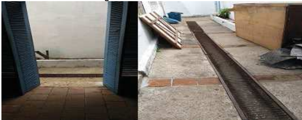
Figura 4- Acesso ao Banheiro
