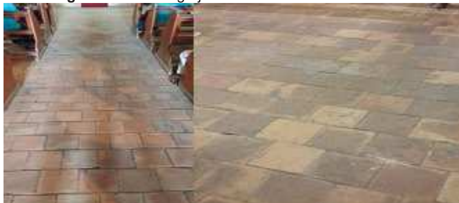
Figura 2- Piso da Igreja da Santa Casa da Misericórdia
