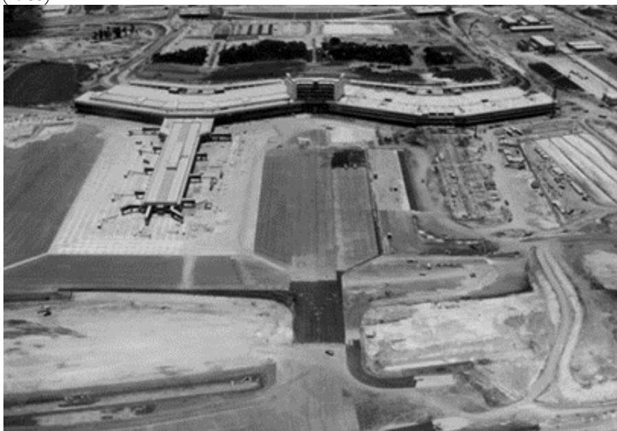
Figura 13 – Construção do Terminal do Aeroporto Internacional de Guarulhos (1985).
