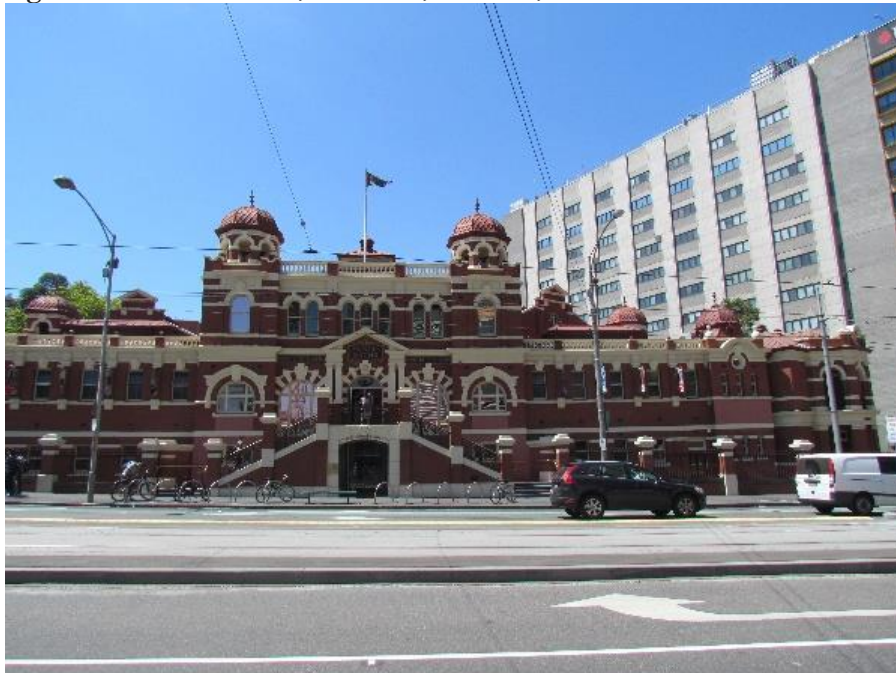
Figura.3. Casa de Banhos, Melbourne, Austrália, 2014.
