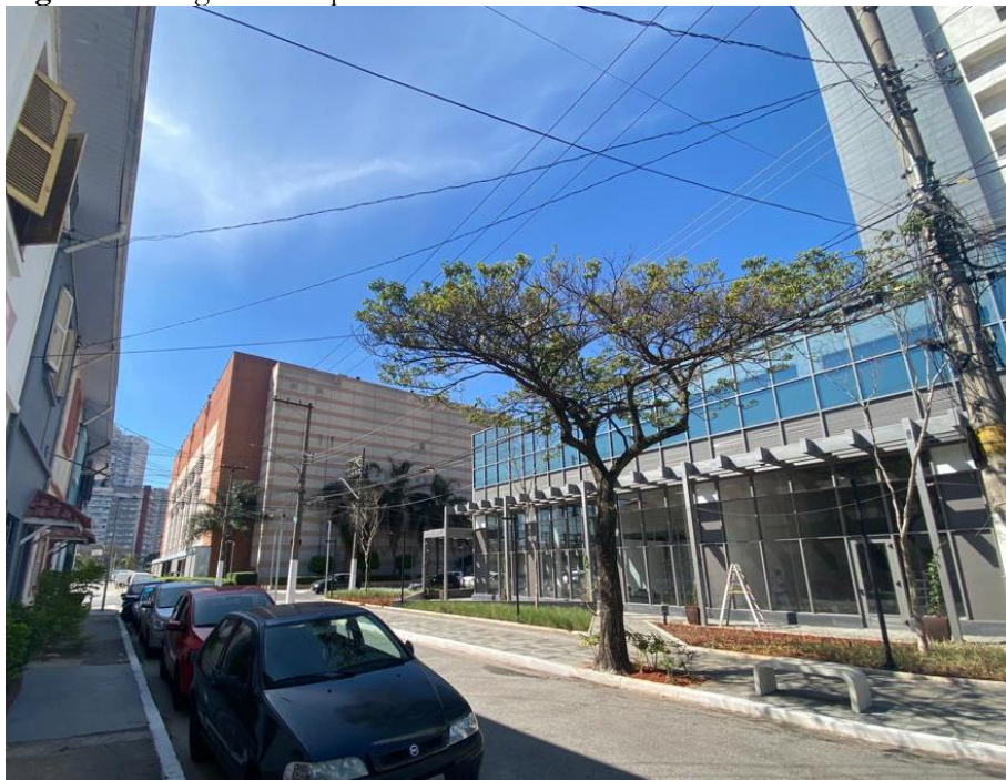
Figuras 18: Legibilidade: prédio escalonado e embasamento.
