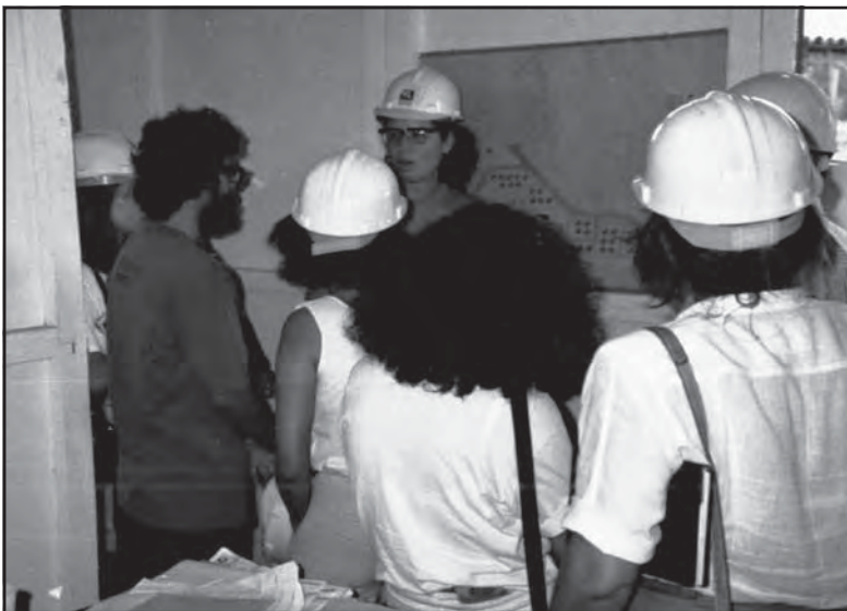
Imagem 20 – Visita a um dos canteiros de obras onde funcionaria uma das salas de alfabetização. A engenheira responsável pela obra foi que nos guiou. 1992. Acervo do autor.
