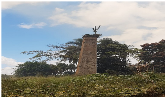
Foto 9. Bueiro do antigo Engenho Taquara, às margens dos Rios Taquara e Jacuípe. Hoje, Usina Taquara. (2017).
