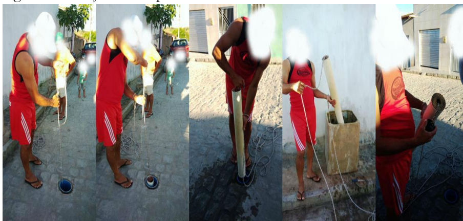
Figura 33 - Poço em via pública.
