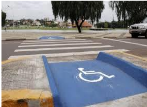
Figura 1: Rampas para rebaixamento de calçadas
