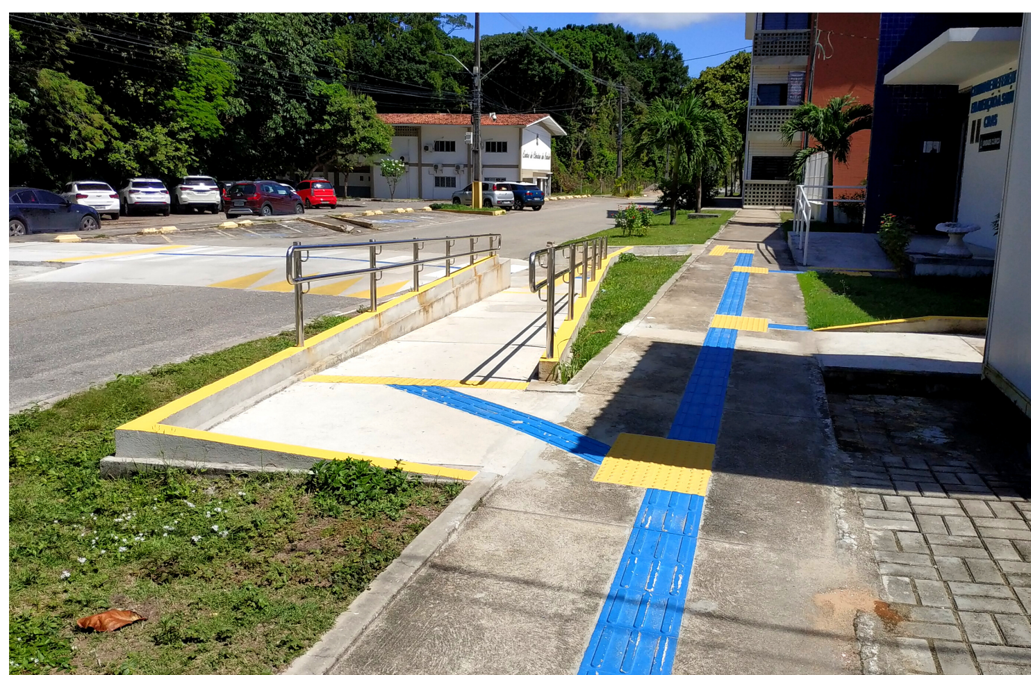
Acesso ao Centro de Referência em Atenção à Saúde (CRAS) no Centro de Ciências da Saúde (CCS) Fonte: autoras
