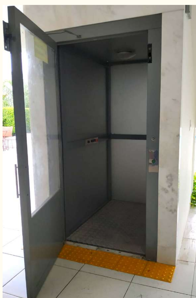
Plataforma Elevatória Fonte: autoras
