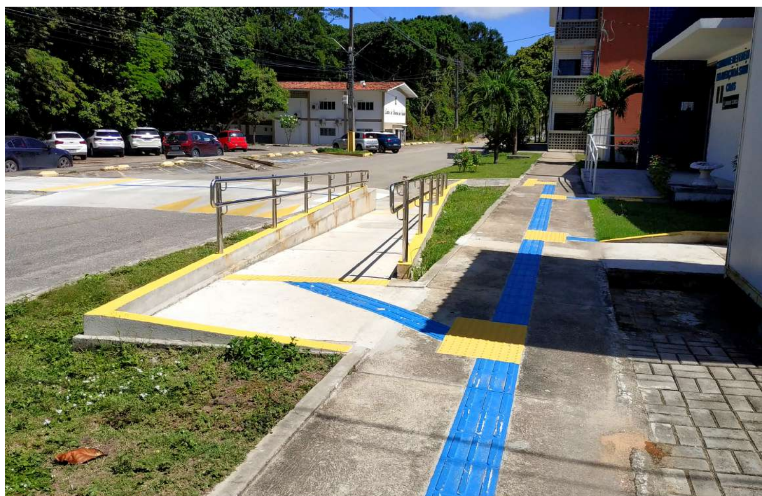
Acesso ao Centro de Referência em Atenção à Saúde (CRAS) no Centro de Ciências da Saúde (CCS) Fonte: autoras
