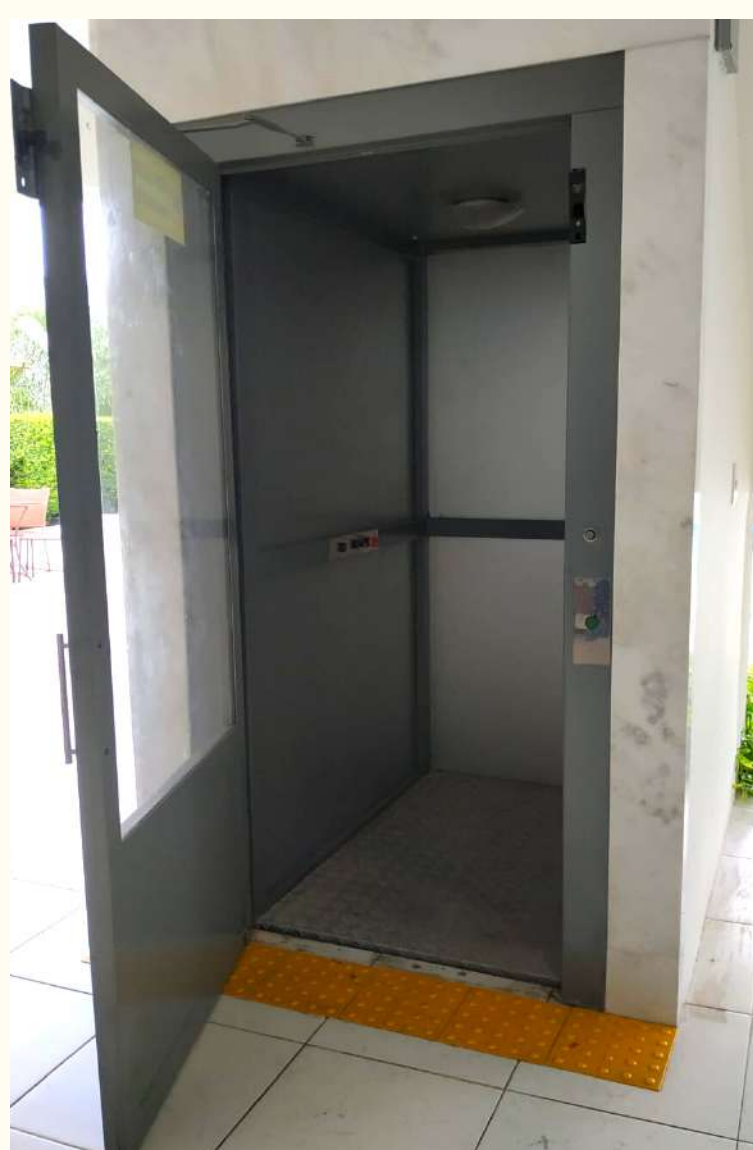
Plataforma Elevatória Fonte: autoras
