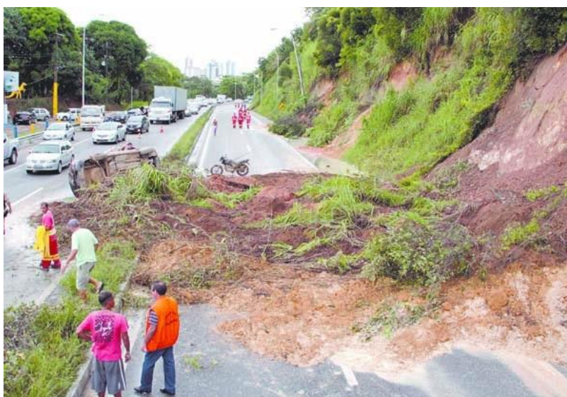
Figura 35 - Deslizamento no talude da BR 230 na comunidade Santa Clara em 2012
