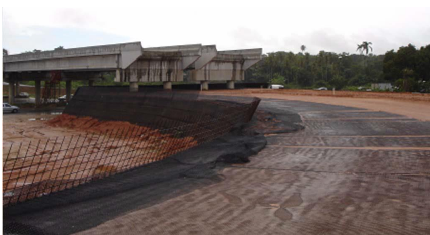
Figura 29 - Aterro construído em solo reforçado em João Pessoa
