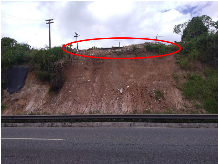
Figura 37 - Talude após demolição de residências em 2019
