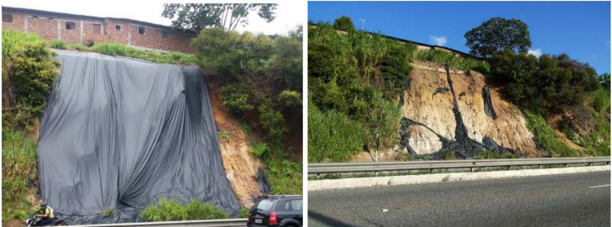
Figura 39 - Antes e depois da instalação da lona plástica
