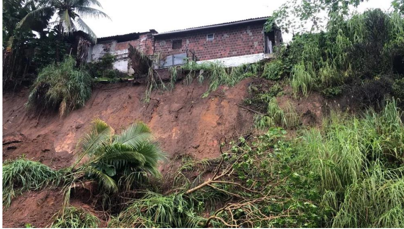
Figura 36 - Deslizamento no talude da BR 230 na comunidade Santa Clara em 2019
