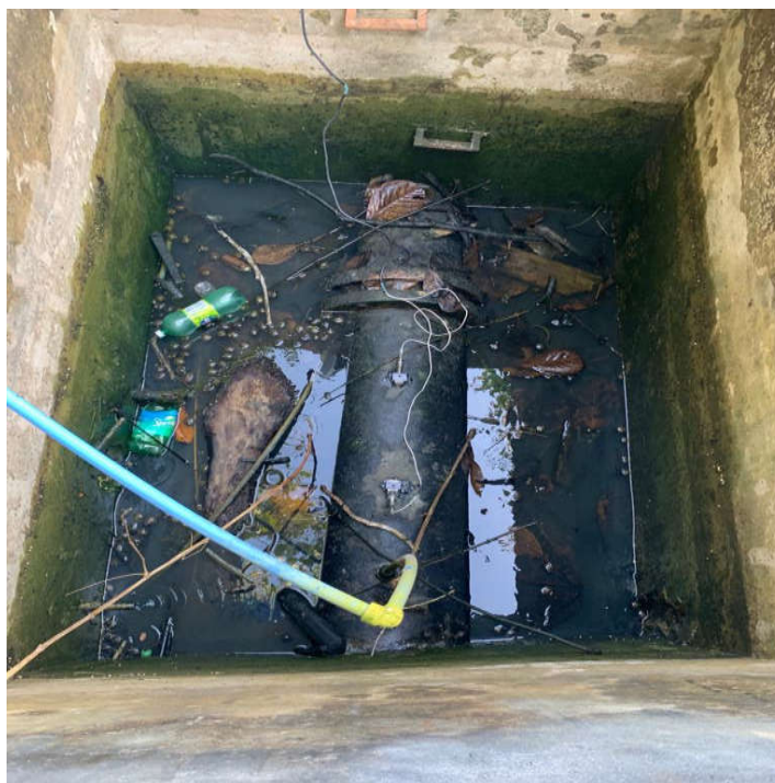
Figura 19 - Caixa de inspeção da adutora 1
