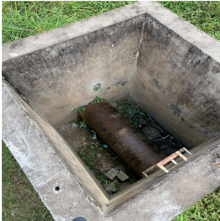
Figura 20 - Caixa de inspeção da adutora 2
