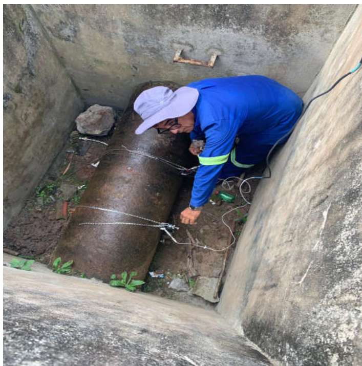
Figura 23 - Colocação dos transdutores no tubo para medir a vazão
