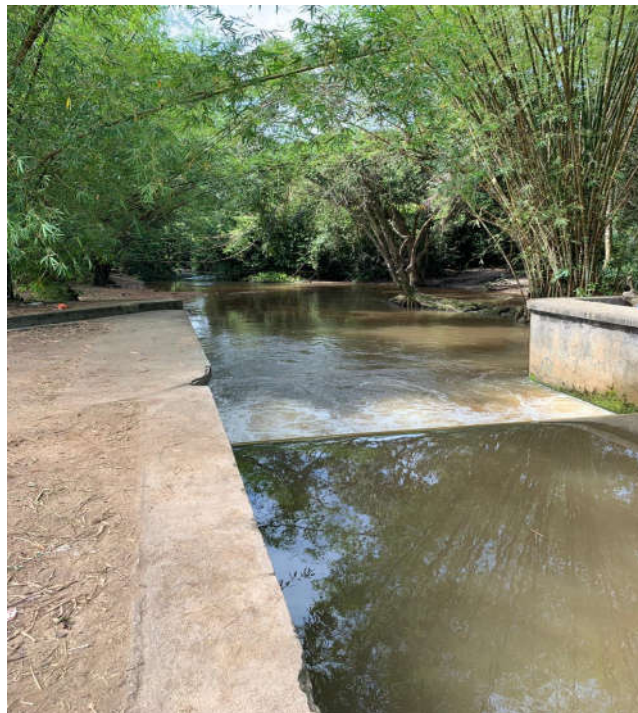
Figura 28 – Barragem de nível do rio Mumbaba
