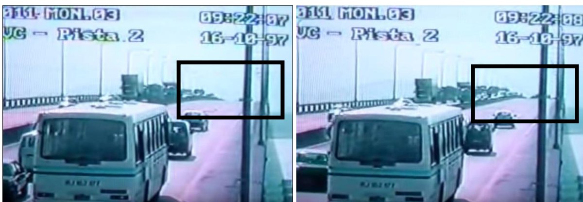
Figura 10 – Vão central da ponte Rio-Niterói balançando
