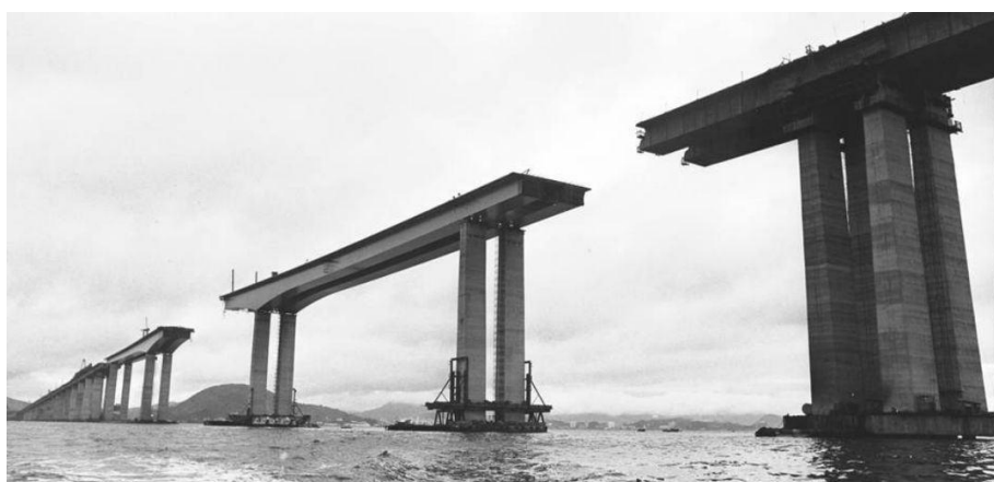
Figura 9 – Ponte Rio-Niterói em construção
