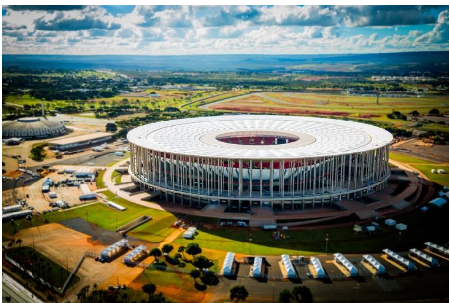
Figura 28 – Estádio Mané Garrincha
