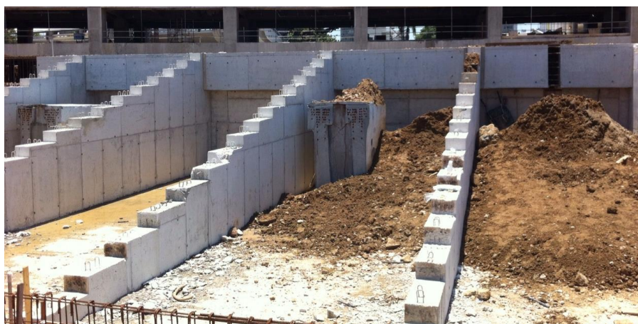
Figura 17 – Construção do contraforte
