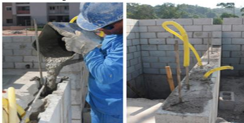
Figura 9 - Grauteamento da alvenaria
