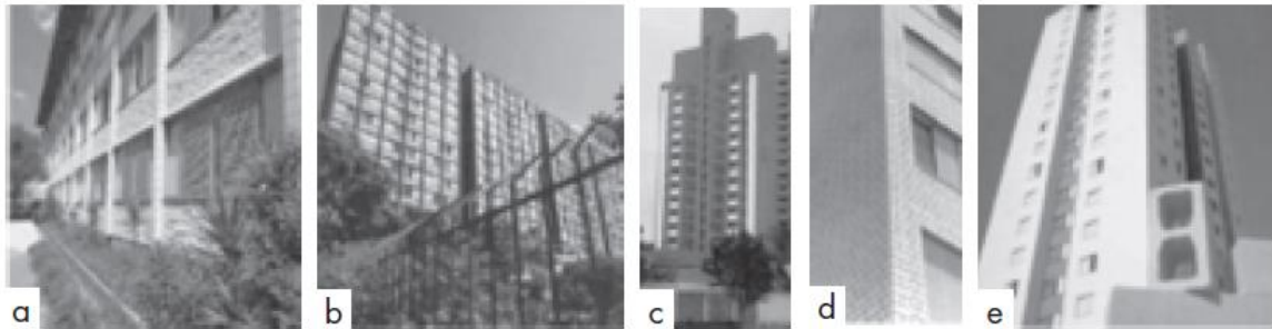
Figura 4 - Condomínio Central Parque da Lapa (a) e Edifícios de 12 pavimentos no Condomínio Central Parque da Lapa (b) Edifício Muriti (c) Edifício Jardim Prudência (d) Edifício Solar das Alcântaras (e)
