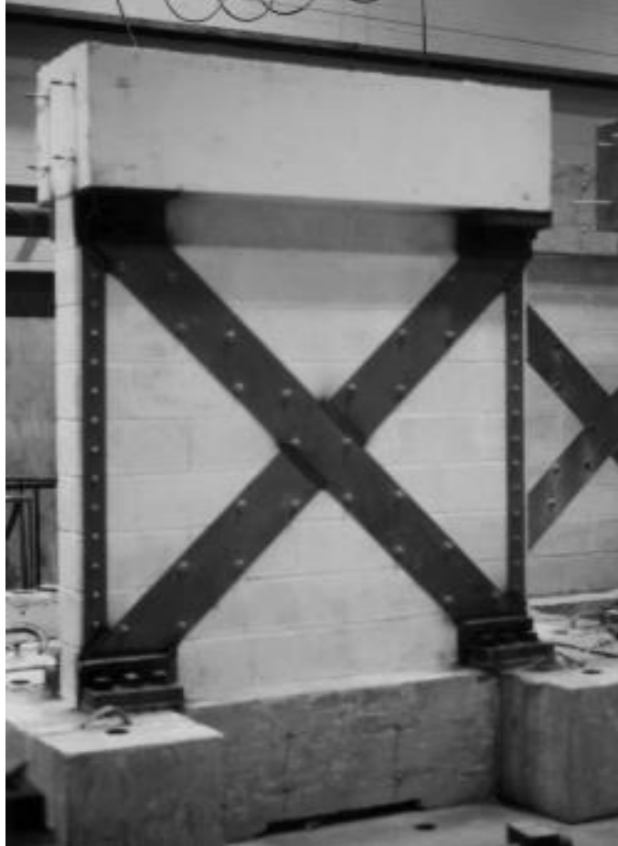
Figura 59 - Incorporação de escoras em parede de alvenaria
