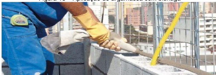
Figura 16 – Aplicação de argamassa com bisnaga
