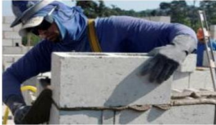
Figura 14 - Retirada do excesso de argamassa em bloco de alvenaria com colher de pedreiro (
