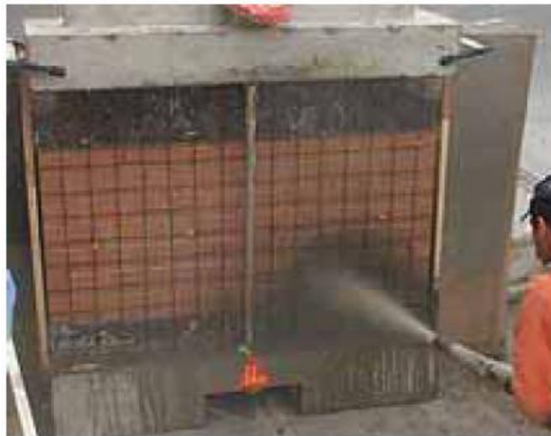
Figura 62 - Aplicação de concreto projetado
