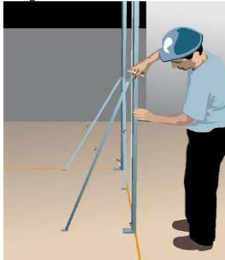
Figura 31 - Transferência de nível
