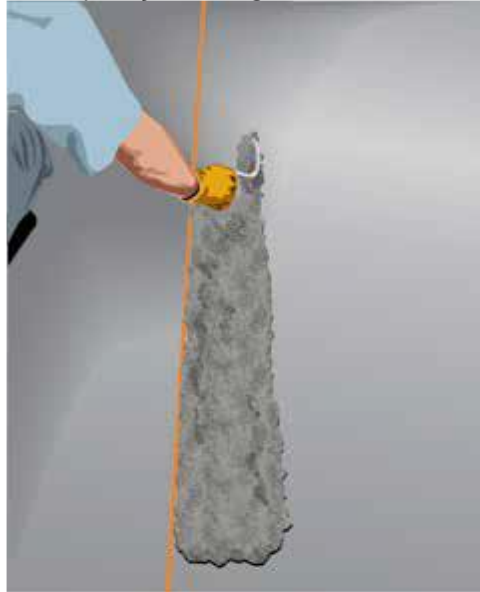
Figura 34 - Aplicação da argamassa de assentamento
