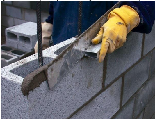
Figura 15 - Aplicação de argamassa com palheta
