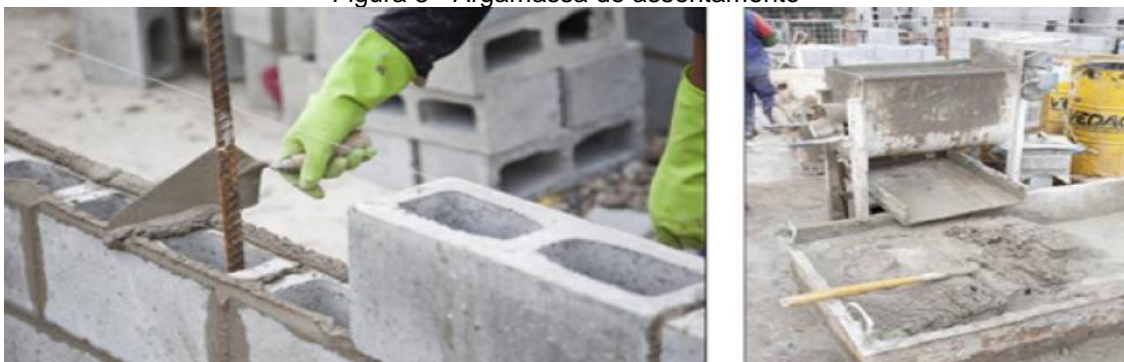
Figura 8 - Argamassa de assentamento
