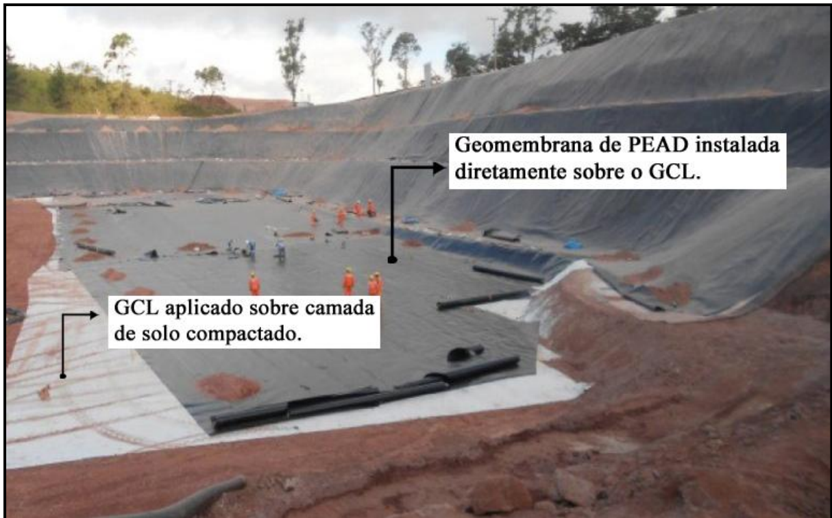
Figura 35 - GCL aplicado sobre camada de solo compactado na ampliação do Aterro de Santo André/SP.
