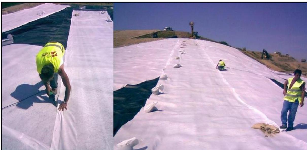
Figura 33 - Instalação do geocomposto drenante (geotêxtil + georrede) de água pluviais em aterro.
