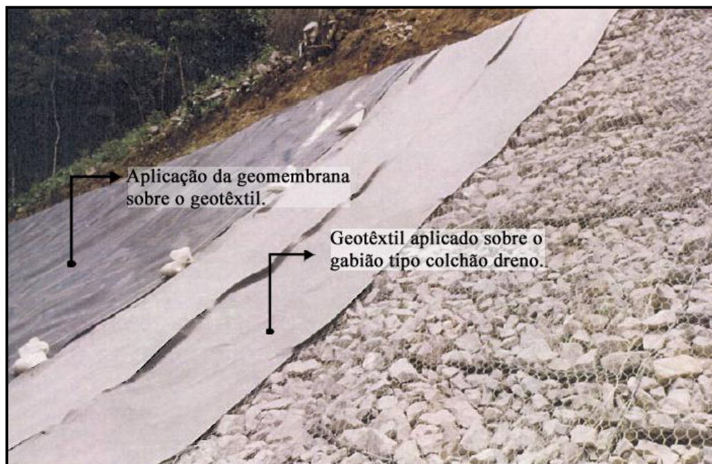
Figura 32 - Aplicação da geomembrana sobre o geotêxtil no Aterro de São Giácomo, na cidade de Caxias do Sul/RS.
