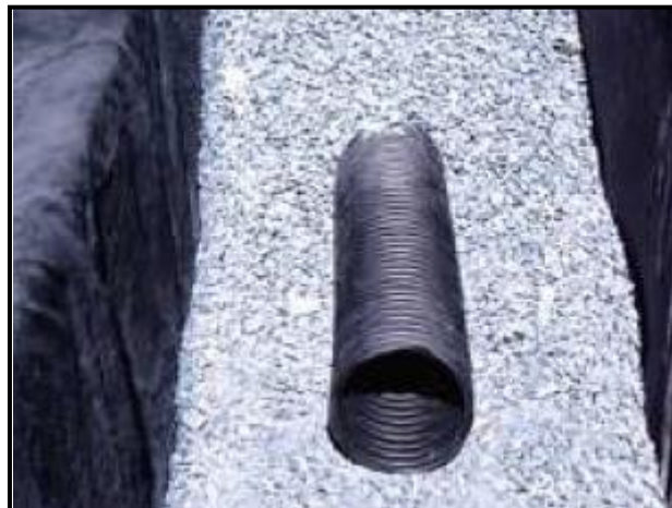
Figura 36 - Aplicação de geotubos em trincheiras drenantes.
