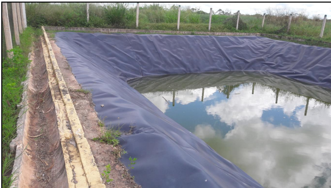
Figura 38 - Geomembrana de PEAD utilizada na impermeabilização da célula de resíduos Classe II-A (Não inertes) no Aterro Sanitário de João Pessoa/PB.
