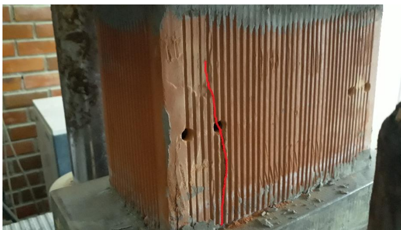
Figura 5.7 – Fissura Observada no Bloco E02 (Tipo 01) após ensaio de compressão axial.
