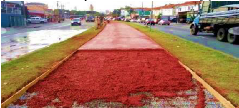
Figura 22 - Pavimentação de ciclovia com concreto pigmentado.
