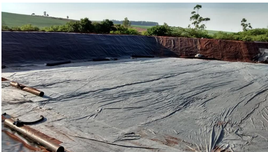
Figura 7 - Geotêxtil não-tecido utilizado como proteção mecânica da geomembrana
