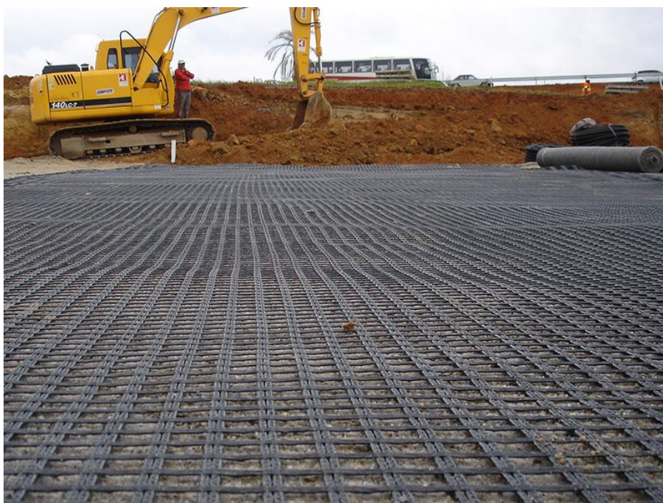
Figura 8 - Uso de geogrelhas para aumentar a capacidade de suporte do solo
