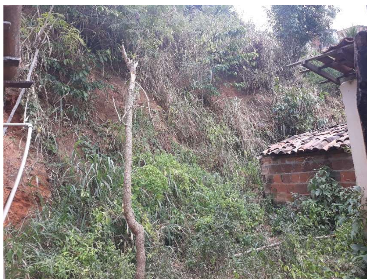
Figura 22 - Local do deslizamento. Fonte: Autor
