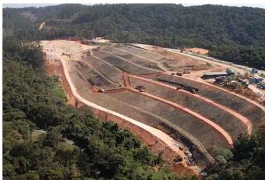
Figura 18 - Retaludamento em aterro sanitário. Fonte: "
