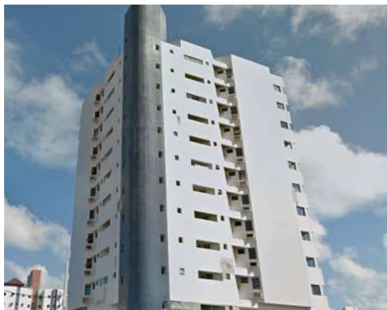
Figura 5-2 – Fachada Oeste Caso 01, em dezembro de 2011
