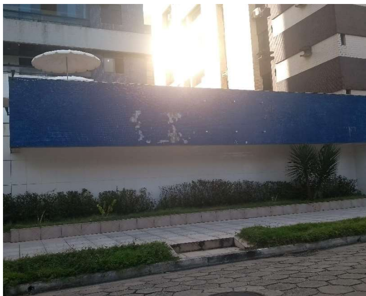
Figura 5-7 – Fachada Sudeste do Caso 03
