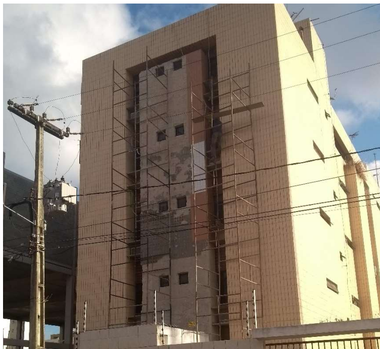
Figura 5-4 – Fachada Nordeste do Caso 02
