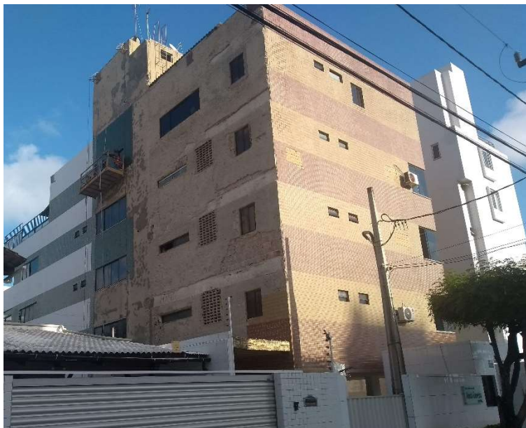
Figura 5-10 – Fachada Nordeste do Caso 04.
