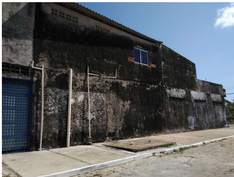
Figura 5-13 – Fachada Sul do Caso 05.
