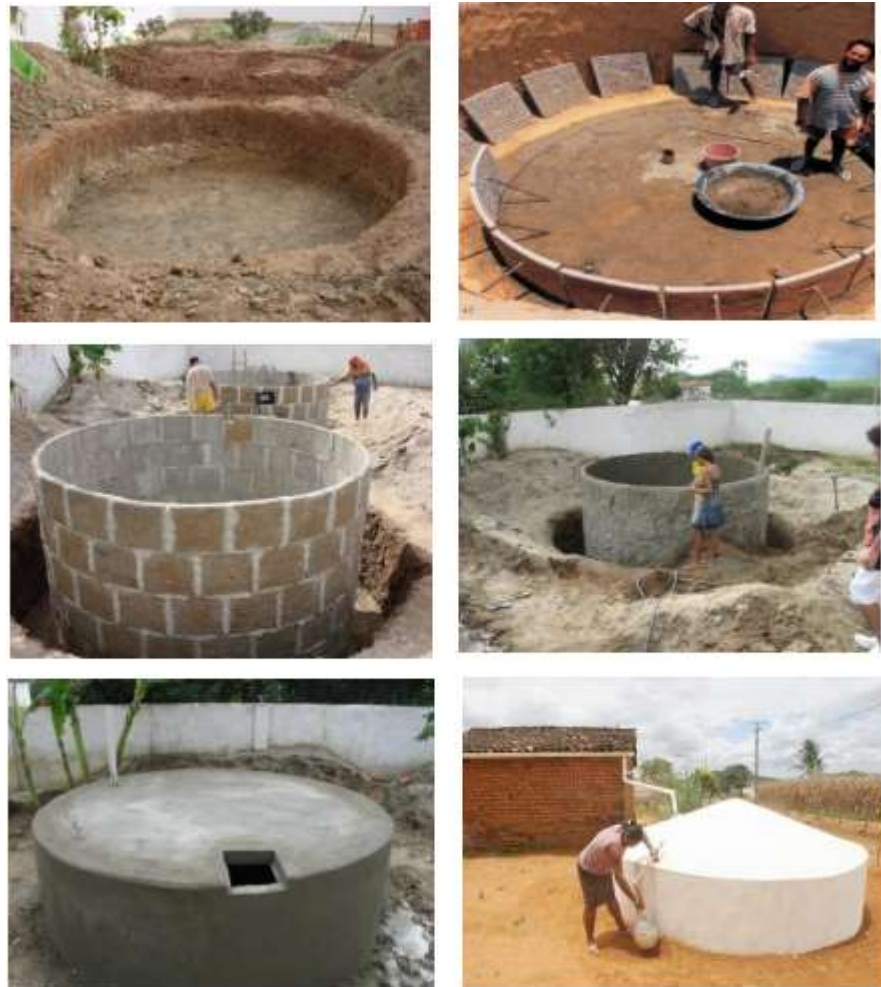
Figura 3.2 – Construção de cisternas de placas pré-moldadas no semiárido nordestino
