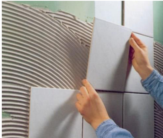
Figura 6 - Aplicação de cerâmica com argamassa colante
