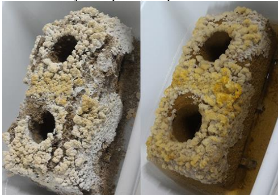
Figura 9: Eflorescência em etapas de secagem e absorção capilar, respectivamente.
