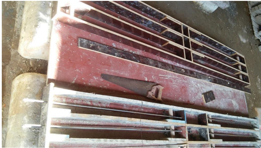
Figura 16: Fôrmas para vergas das paredes
