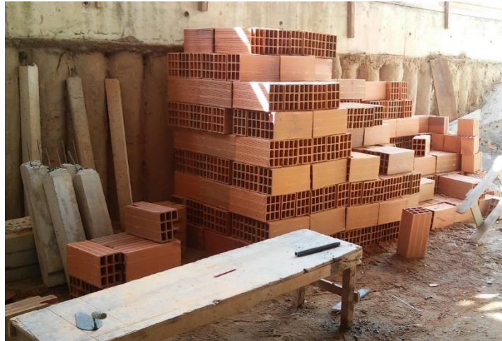
Figura 18: Armazenamento de blocos cerâmicos substitutos dos blocos pré-moldados com concreto
