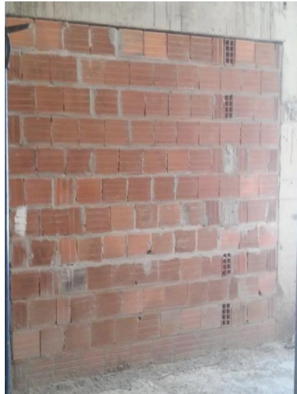
Figura 3: Parede em alvenaria tradicional
