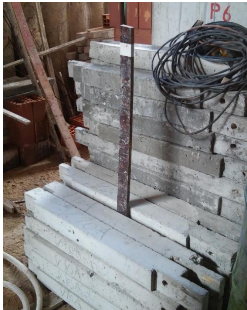
Figura 17: Armazenamento de vergas na obra
