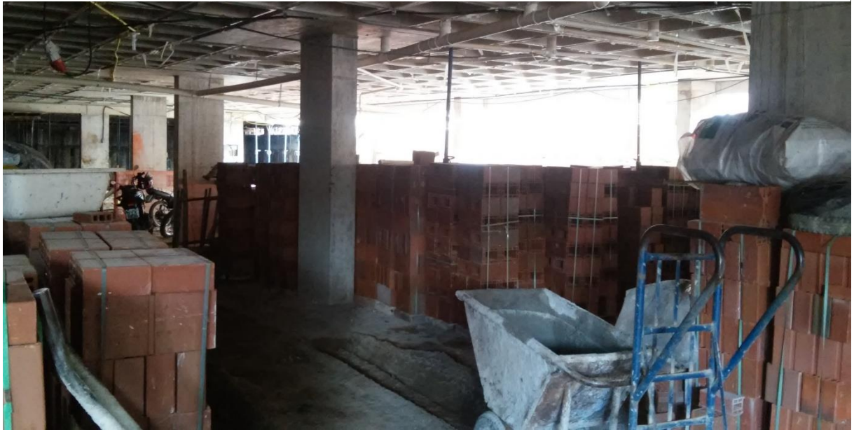
Figura 13: Blocos cerâmicos armazenados sob a laje do pavimento térreo
