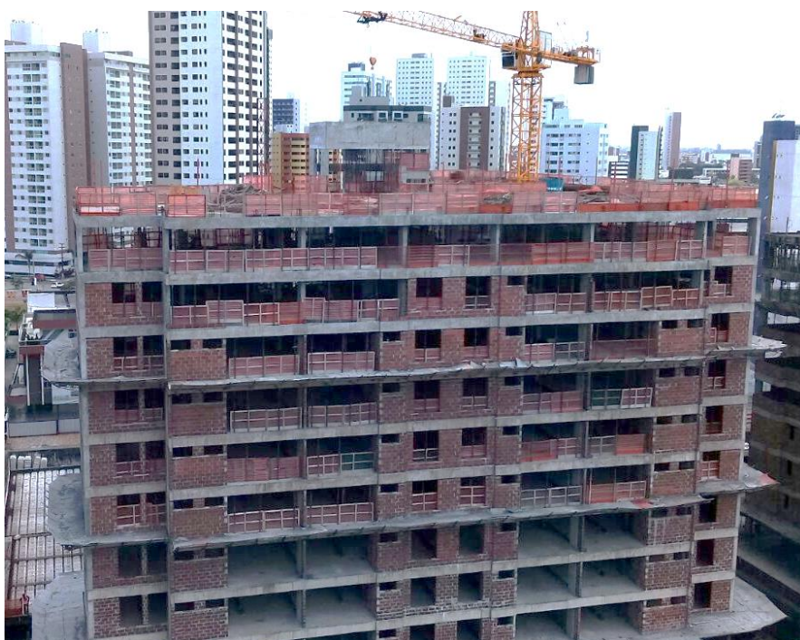
Figura 8: Alvenaria externa da fachada frontal da torre A do edifício
