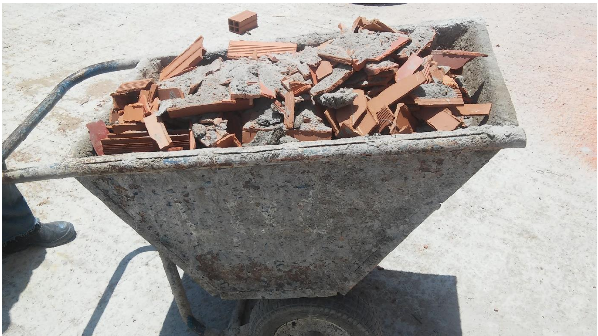
Figura 20: Desperdícios de blocos racionalizados
