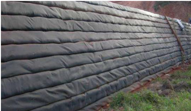
Figura 14. Geotêxtil aplicada em reforço de solo Fonte: Geossintec
