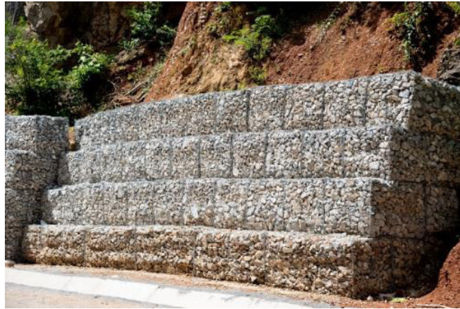
Figura 20. Contenção com muro de gabões. Fonte: Escola Engenharia
