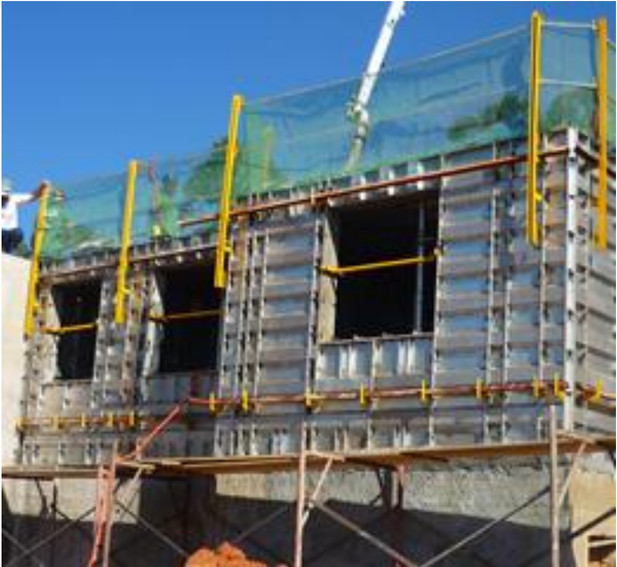
Figura 4 – Painéis de alumínio para estrutura em concreto
