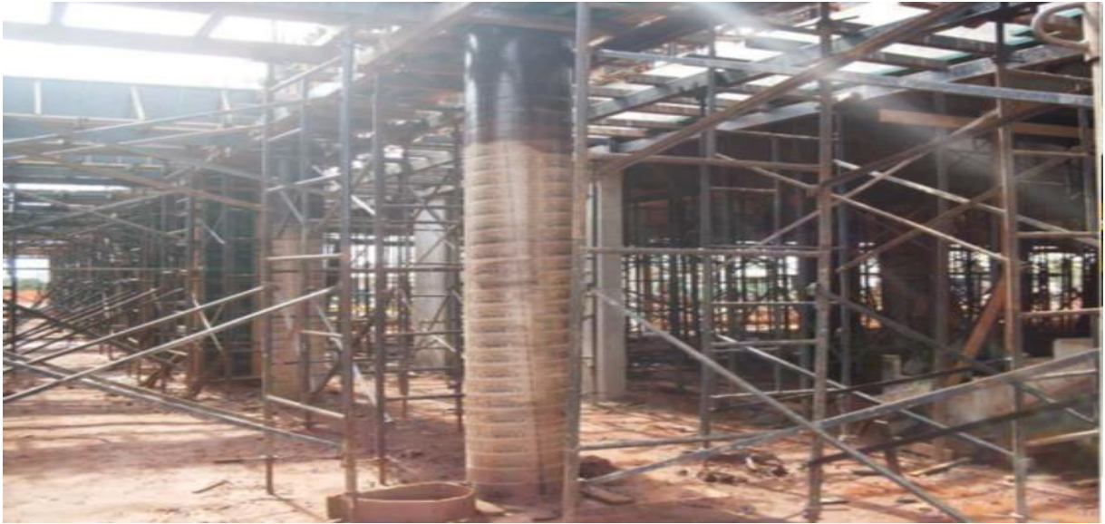
Figura 2 - Forma de papelão em pilar circular
