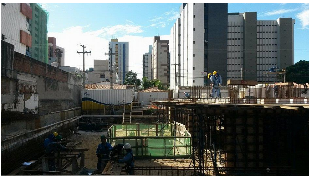
Figura 9 – Escoras metálicas para laje de concreto
