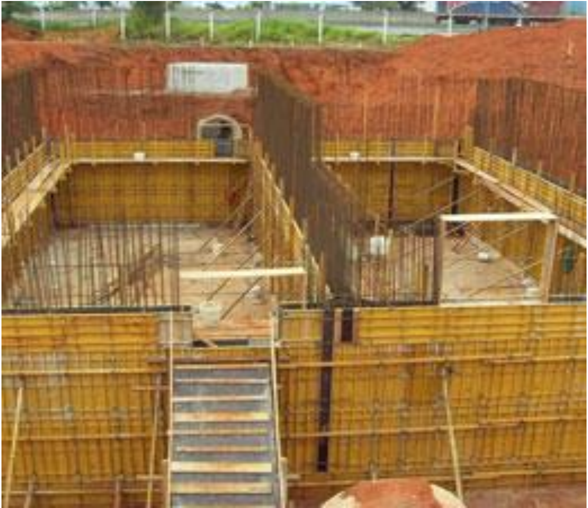
Figura 3 – Painéis de aço para estrutura de concreto
