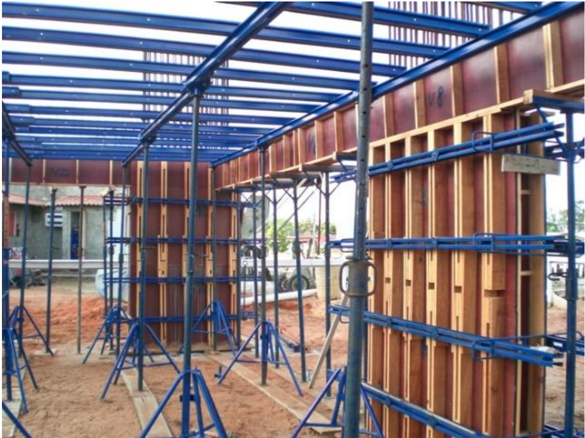
Figura 11 – Escoramento para lajes em vigas metálicas
