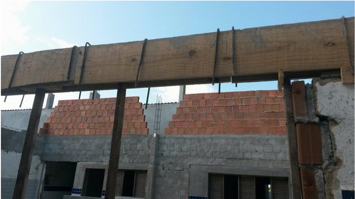
Figura 7 - Forma de tábuas de madeira utilizada em vigas
