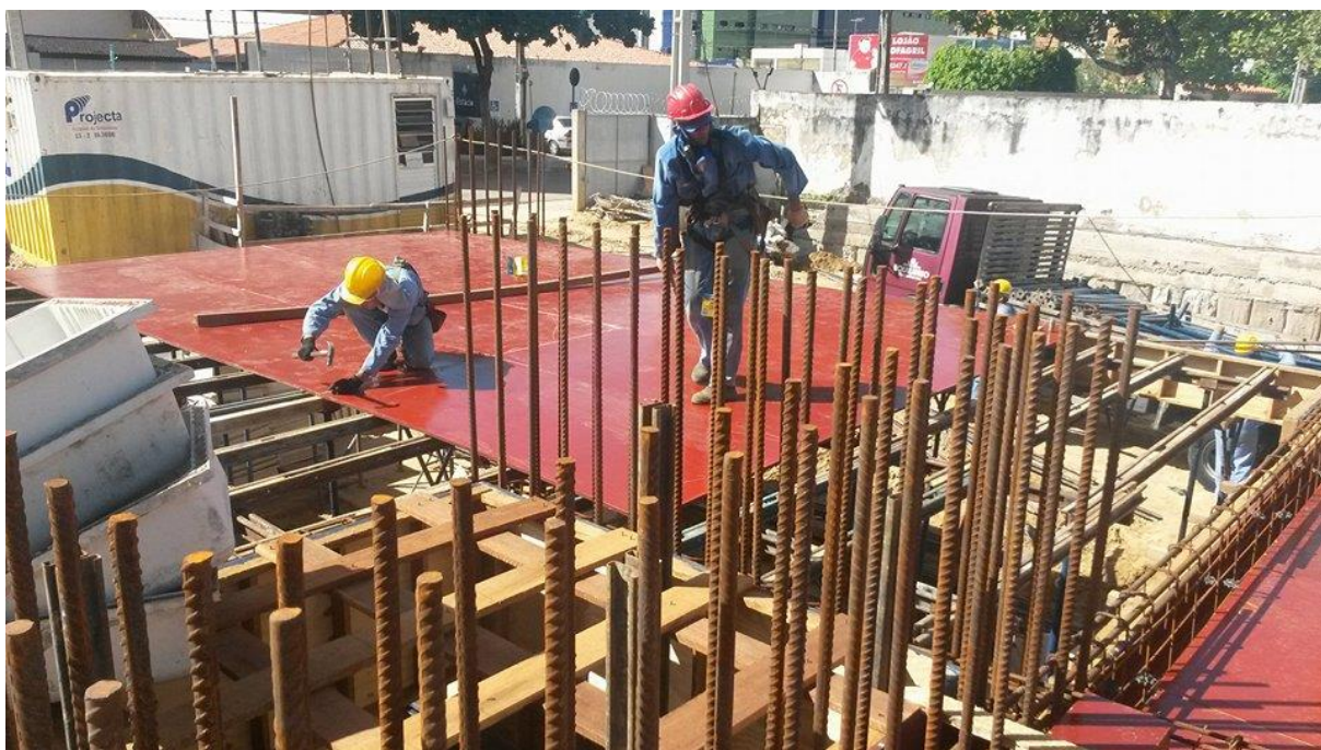
Figura 5 - Fixação do assoalho em chapas compensadas resinadas
