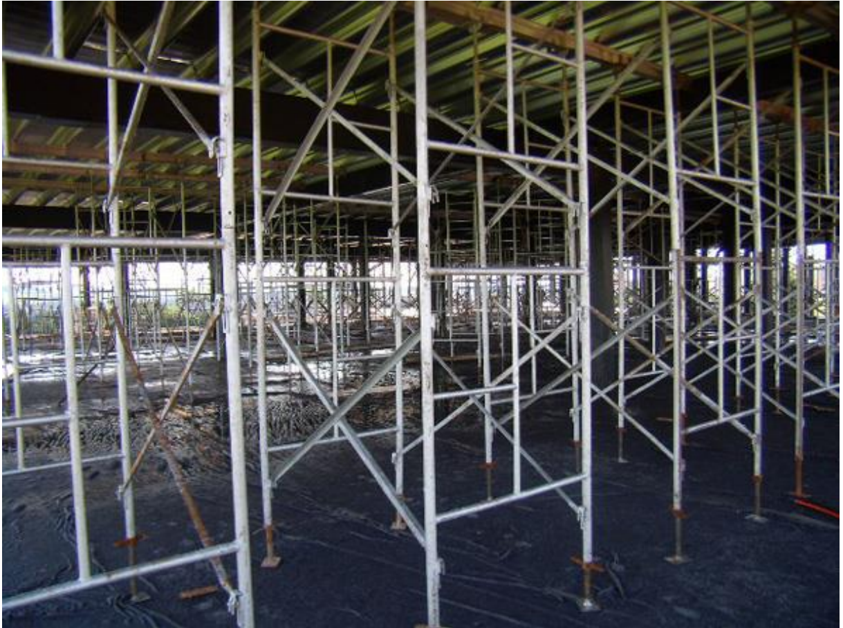
Figura 14 – Escoramento com torres metálicas
