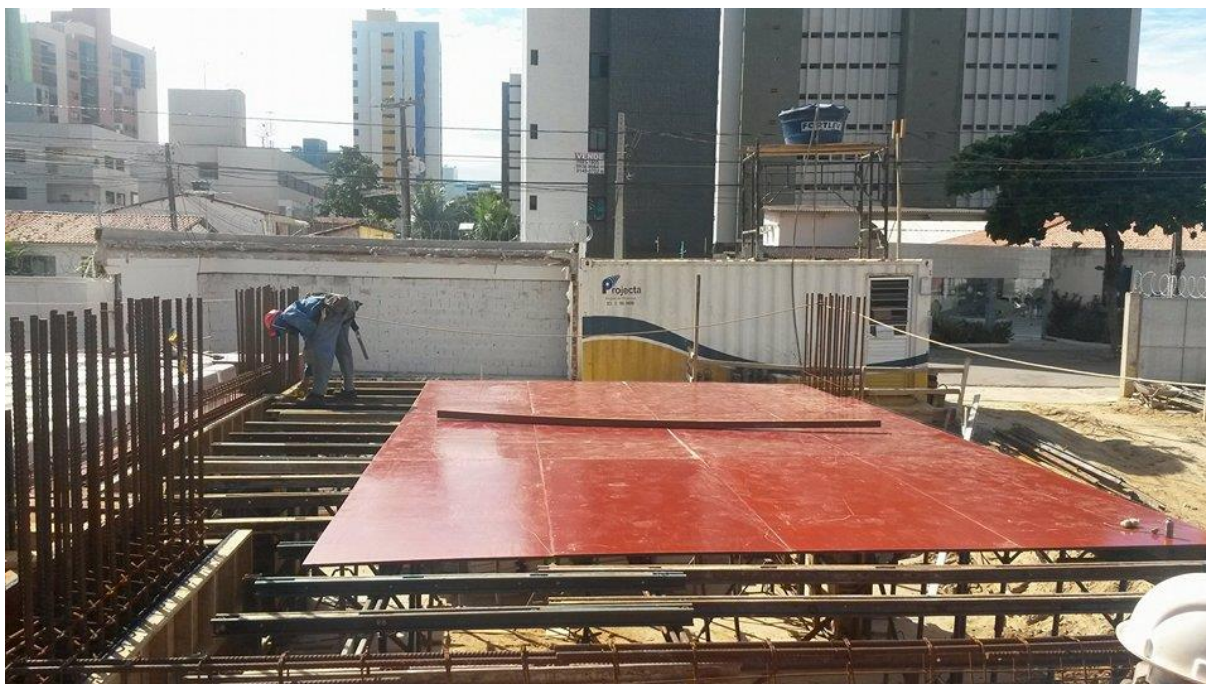
Figura 6 - Disposição da chapa de madeira sobre as longarinas metálicas
