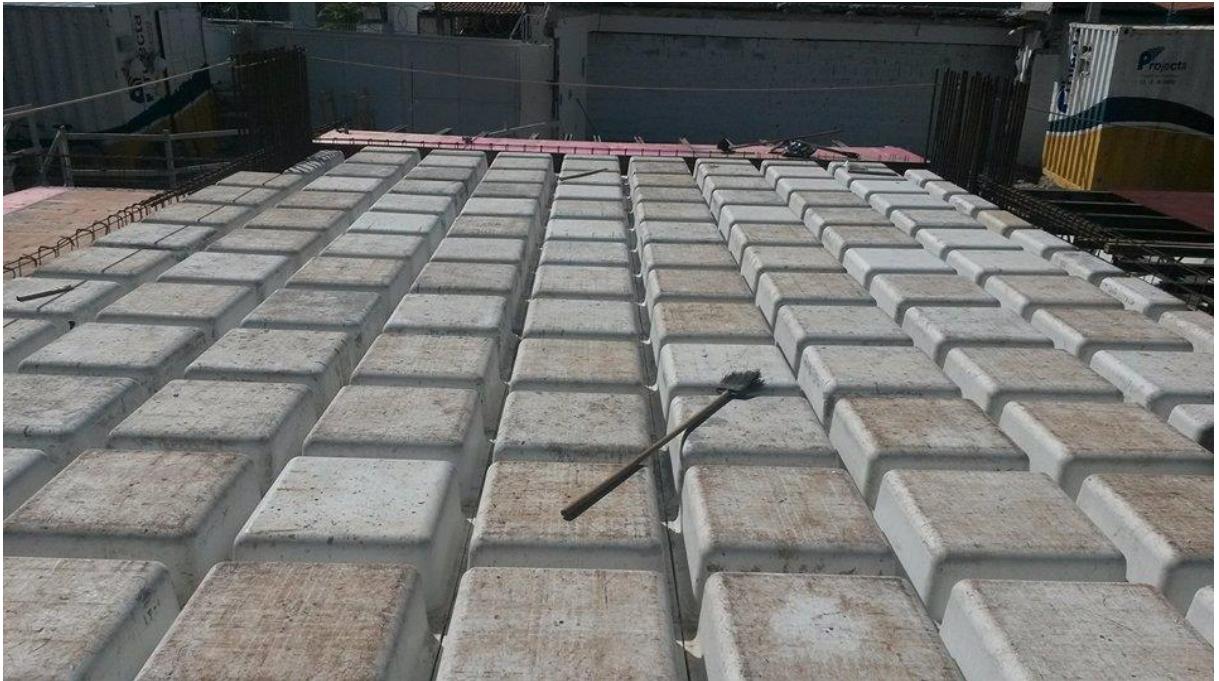
Figura 1- Formas Plásticas -1º laje de concreto
